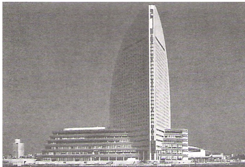
Figura 17: Yokohama Grand Inter-Continental Hotel, Yokohama, Japão. Arquitetos: Nikken Sekkei Fonte: LAWSON, 2003, p.162.
