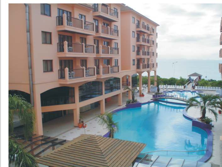
Figura 56: Vista lateral interna, exemplar 07. Fonte: autor.
