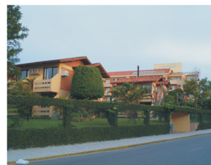
Figura 61: Vista geral do hotel, exemplar 10. Fonte: autor.
