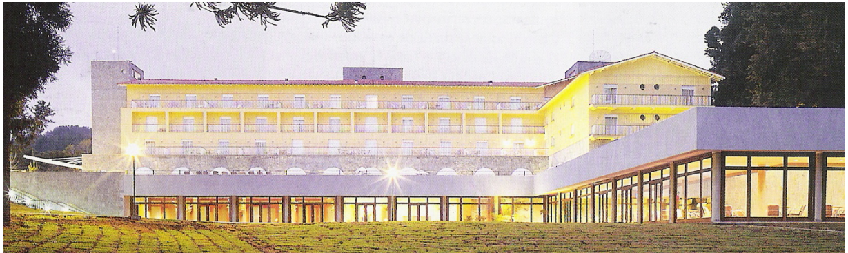
Figura 34: Grande Hotel de Campos do Jordão. Campos do Jordão, SP, Brasil. Arquiteto: Ricardo Chahin. Fonte: REVISTA PROJETO, nº 224, setembro de 1998, p.41.
