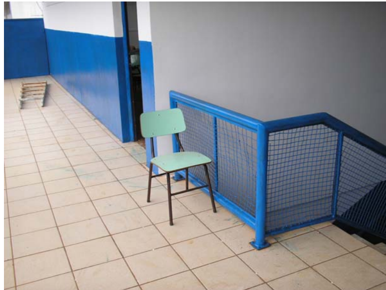
FIGURA 33: Detalhe da altura do guarda corpo, o espaldar da cadeira de 65cm.
