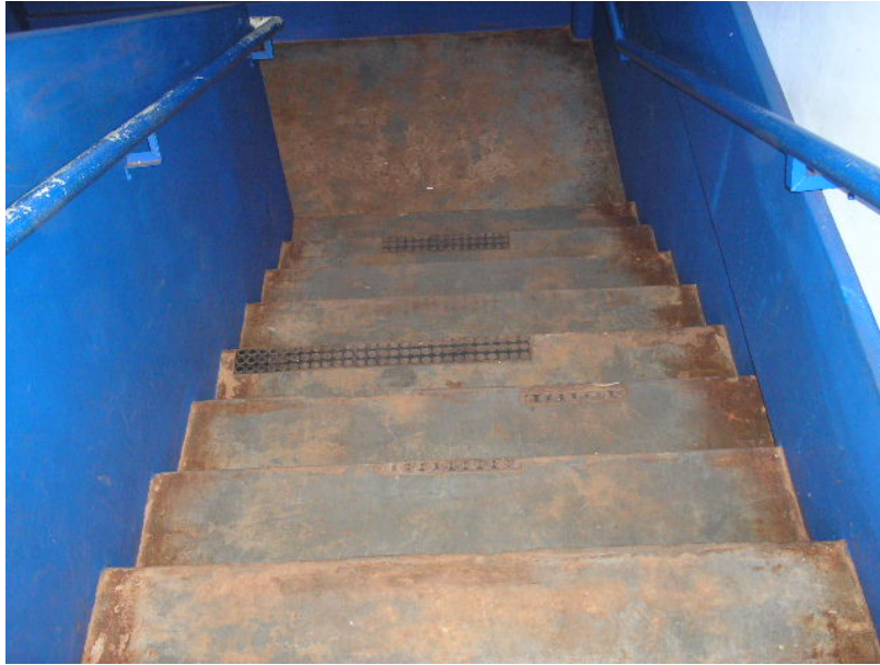
FIGURA 21: Uma das escadas da escola. Podem-se observar restos de borracha sintética.
