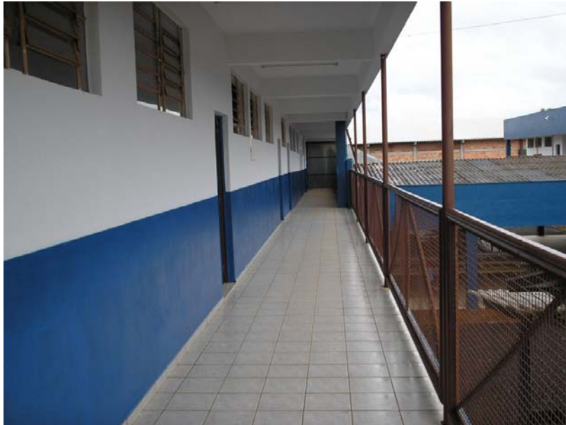
FIGURA 30: Corredores de acesso a salas de aula.
