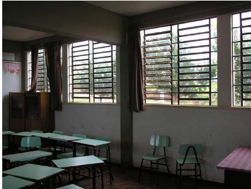
FIGURA 12: Janelas de ferro e vidro tipo basculante
