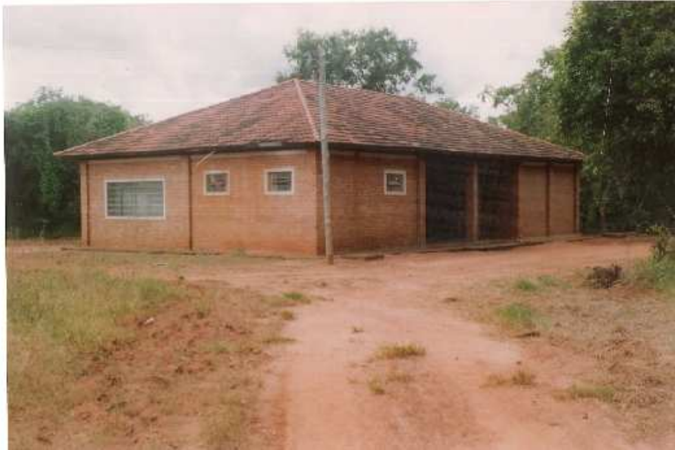
Foto 8 – Vista lateral da escola
