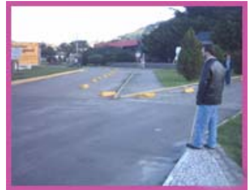
Figura 24: Ausência de sinalização Fonte: acervo pessoal
