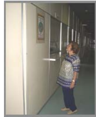
Figura 02: Placa revestida com material brilhoso dificulta leitura de pessoas com baixa visão. Fonte: acervo pessoal
