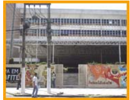
Figura 17: Acesso Av. Gentil Bittencourt.
