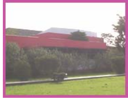
Figura 20: Fachada CIC Fonte: acervo pessoal
