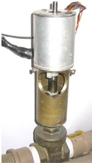
**Figura 30 - Válvula de controle da extremidade da tubulação**
