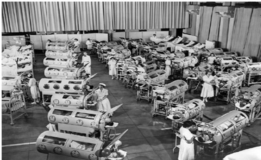
**FOTO 2 – UTI COM VENTILADORES CICLADOS A VÁCUO**
