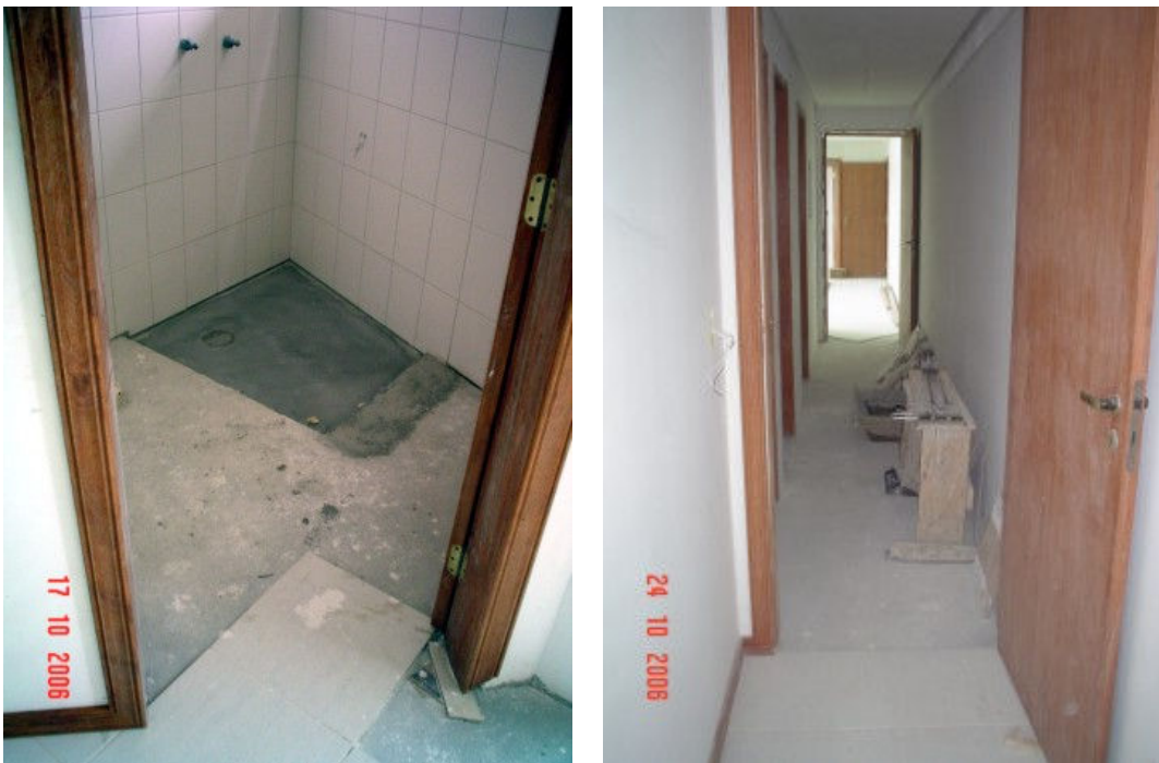
Figura 16 – Esquecimento de aplicação de piso cerâmico (dados da pesquisa).
