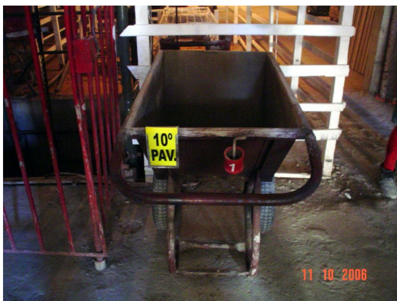
Figura 36 – Carrinho identificado com o local (10º pav.) e o tipo de argamassa (tipo 1) (dados da pesquisa).
