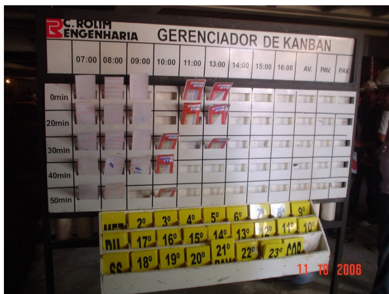
Figura 34 – Sistema de gerenciamento da betoneira (dados da pesquisa).
