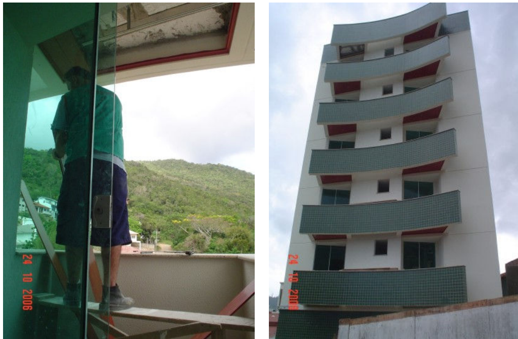
Figura 23 – Operário executando o forro de PVC, na varanda do quinto pavimento da obra T (dados da pesquisa).
