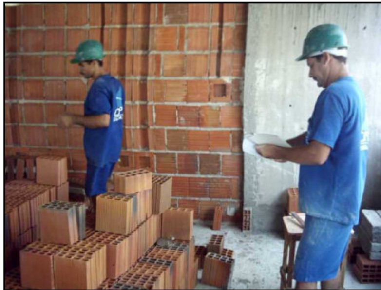
Figura 31 – Detalhe do operário estudando o caderno de execução de alvenaria. Fonte: Heineck (2005).
