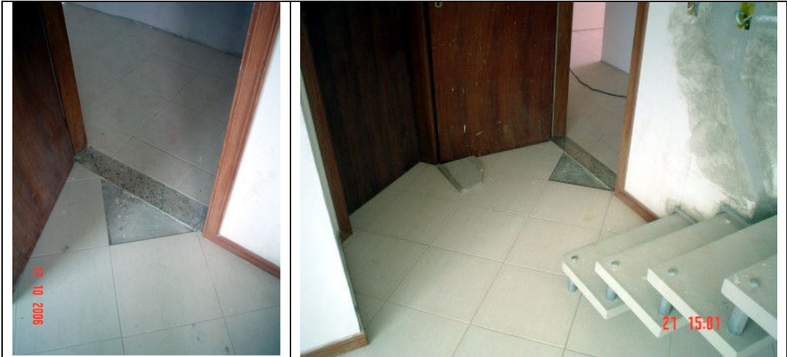
Figura 18 – Falta de informação sobre a necessidade de execução de retoque de piso cerâmico (dados da pesquisa).
