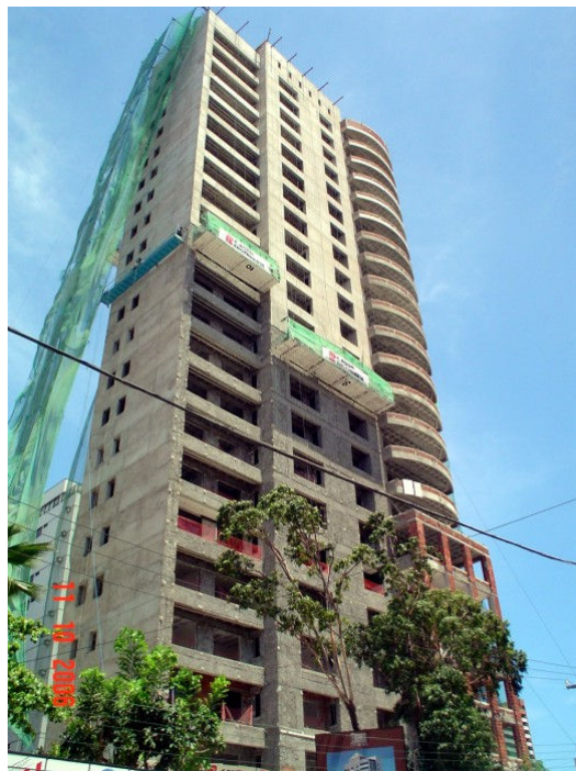
Figura 26 – Fachada do edifício (dados da pesquisa).
