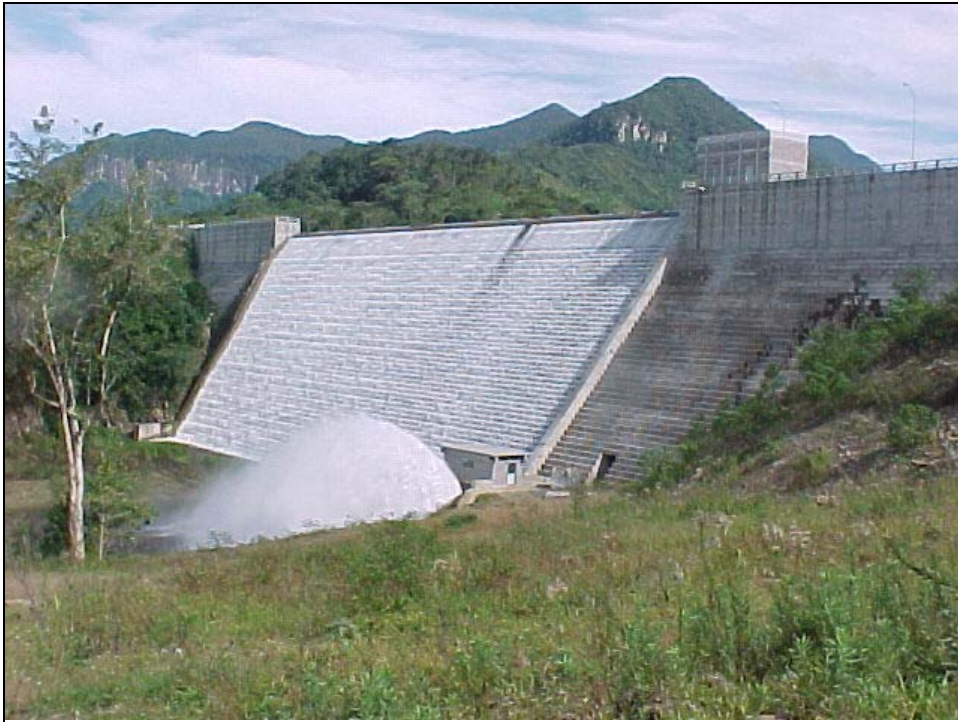
Figura 13: Barragem do Rio São Bento – Vertedor.
