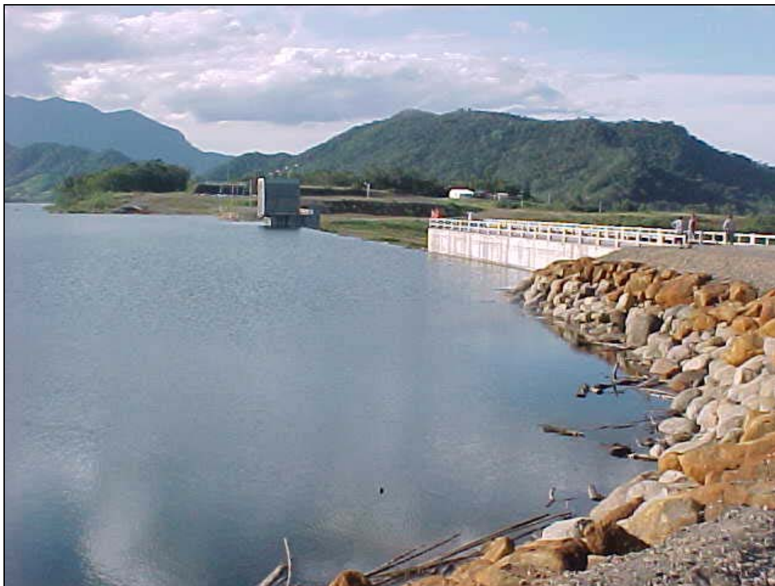
Figura 11: Barragem do rio São Bento – Lago Formado pelo Aproveitamento.
