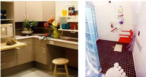
**Figura 65: Cozinha com bancadas rebaixadas e banheiro com barras e banco de apoio.
