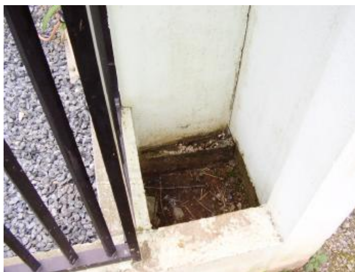
Figura 21: Cavalete inexistente
