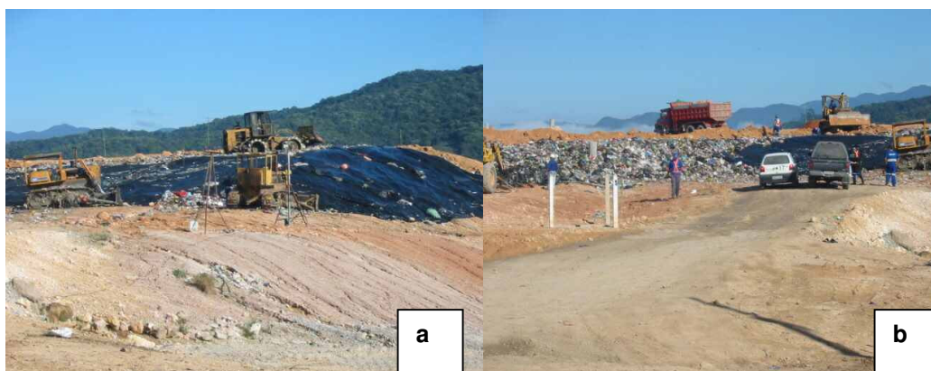
Figuras 5.1(a) e (b): Descarregamento e compactação dos resíduos sólidos no aterro sanitário de Biguaçu.
