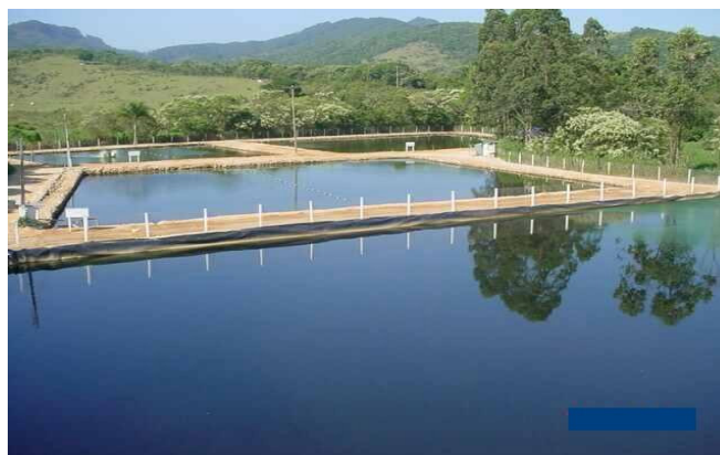
Figura 5.3: Lagoas de estabilização tratando o lixiviado no aterro sanitário de Biguaçu.
