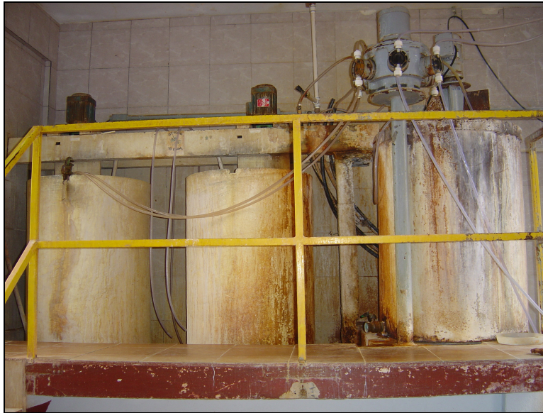
Figura 41: Tubos contendo Sulfato de Alumínio e Barrilha – ETA de Coronel Vivida. Os dois primeiros tubos da esquerda para a direita contêm sulfato de alumínio, enquanto que no terceiro há barrilha, um alcalinizante que serve para diminuir a acidez da água. (Foto da autora 15/05/2005).
