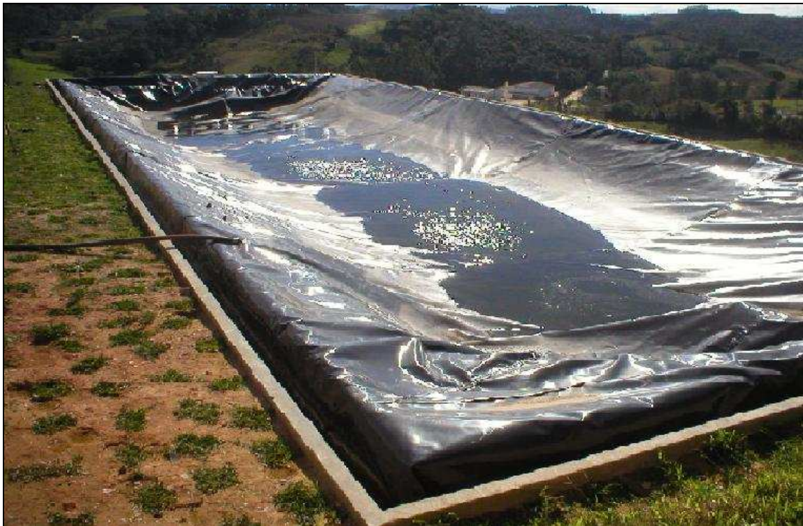
Figura 4.8 – Vista externa da lagoa anaeróbia (LA)
