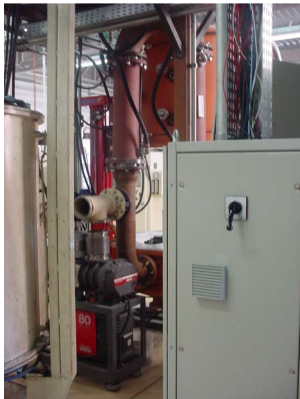
Figura 33. Montagem do sistema de vácuo e trocadores de calor.
