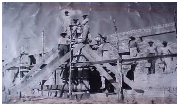
Figura 01 - Escola de Iniciação Agrícola em construção.
