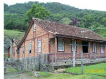
Imagem 71: Construção antiga. Fonte: Acervo do autor.
