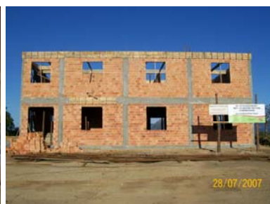
Imagem 43: Construção fundação. Fonte: Acervo do autor.
