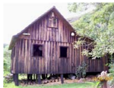
Imagem 55: Construção antiga. Fonte: Acervo do autor.
