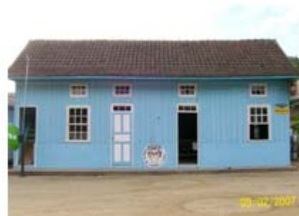
Imagem 20: Construção antiga. Fonte: Acervo do autor.
