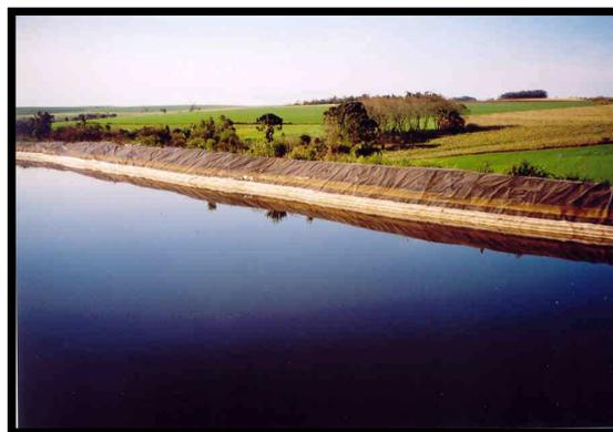
**FIGURA 22 – Tanque de contenção do percolado proveniente do aterro e do pátio de compostagem - 2005**
