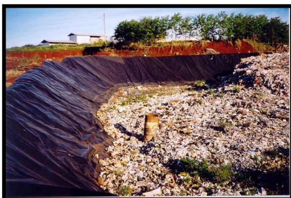
**FIGURA 21 – Aterro controlado com geomembrana sintética, drenagem de gás e sem cobertura diária - 2005.**
