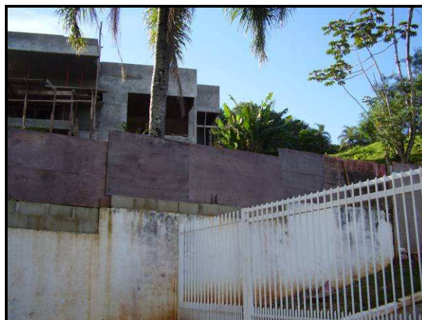
Figura 15. Casa em processo de edificação no Condomínio Casablanca
