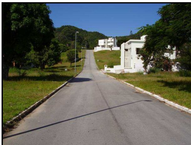
Figura 7. Interior do Condomínio Farol da Ilha Autora: Aline Schaefer Körbes. 12/08/2006
