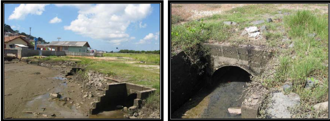
Figuras 81 e 82: detalhes da porção sul do canal da Costeira, fechada em 2005, e as três pequenas ligações do interior do canal com o mar. Na Figura 82 (direita), detalhe de uma dessas ligações; é perceptível a quantidade de sedimento que cobre parcialmente estas canalizações, demonstrando que as mesmas não suprem satisfatoriamente o escoamento de água e sedimentos para fora do canal. Na Figura 81 (esquerda), percebe-se também o acúmulo de sedimentos, que forma uma espécie de “rampa” de sedimentos, que vai rebaixando em direção ao interior do canal, no sentido norte (fotos do autor, em março de 2008).
