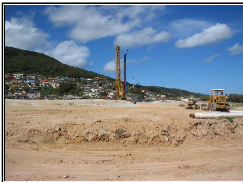
Figura 40: Obras de aterramento e fechamento do canal da Costeira, para ligar a Via Expressa Sul às vias de acesso ao Sul da Ilha. Neste ponto, também houve a supressão da cobertura vegetal, impactando todas as faixas (transição, arbóreas e Spartina ) e as duas principais manchas de vegetação do Setor Sul (foto do autor, em agosto de 2004 – ver também Figuras 7, 8, 28 e 29).
