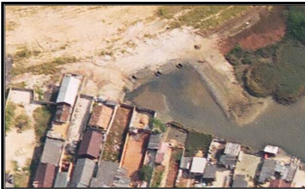
Figura 83: vista aérea da porção sul do canal da Costeira, fechada quase totalmente pelo aterramento, exceto pelas três canalizações. Nesta foto, de 2006, já é percebido o acúmulo maior de sedimento neste local. Foto cedida (recorte) pelo Prof. Dr. Joel Pellerin (GCN/CFH/UFSC), feita em fevereiro de 2006, durante vôo com o helicóptero da Polícia Militar de Santa Catarina/PMSC.
