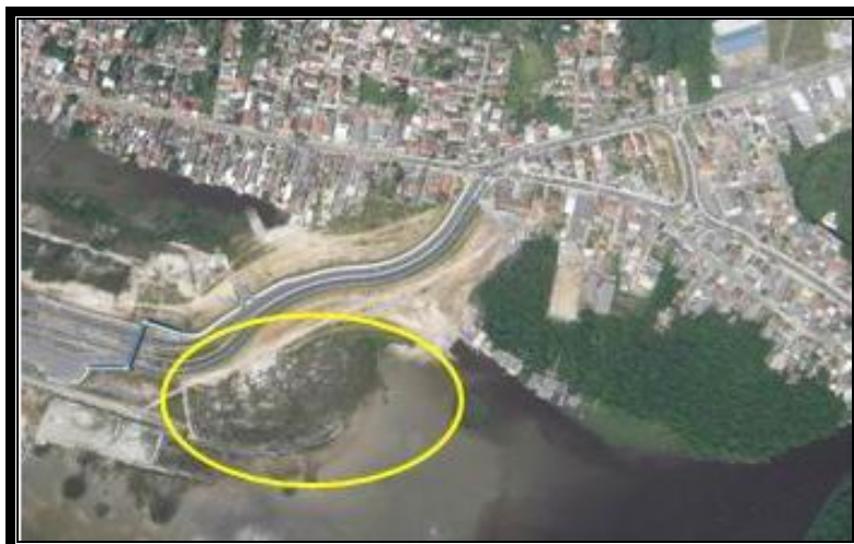
Figura 93: Outra fotografia mostrando a porção sul da área de estudo, que possibilita visualizar a área de vegetação isolada (destacada pela elipse amarela), após o fechamento do canal da Costeira, e a execução da parte final da Via Expressa Sul (ver também mapas e encarte). Foto cedida pelo Prof. Dr. Joel Pellerin (GCN/CFH/UFSC); feita em junho de 2004.
