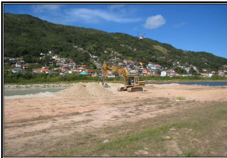
Figura 39: Obras de remobilização do aterro, na margem esquerda do canal da Costeira, para finalização da Via Expressa Sul (ligação com as vias de acesso ao Sul da Ilha). Estas obras destruíram parte da vegetação de transição, o que reverteu em uma diminuição em sua área total, entre os anos de 2002 e 2004 (foto do autor, em agosto de 2004).
