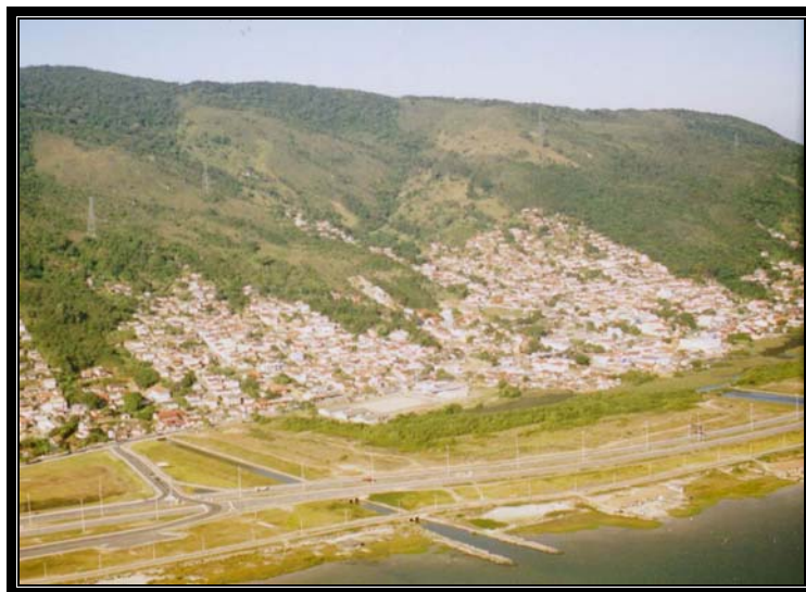
Figura 95: vista aérea de parte da orla do aterro, e a porção norte do canal da Costeira. A intensa ocupação das encostas do entorno do aterro (na foto, bairro da Costeira do Pirajubaé), acarreta no lançamento de grande quantidade de esgoto in natura, bem como de resíduos sólidos, em direção ao mar e ao canal. Isto ocorre pela imensa carência de infra-estrutura, incluindo tratamento de esgoto e coleta de lixo, infelizmente uma situação corriqueira nos bairros destas áreas de situação sócio-econômica precária. Foto cedida pelo Prof. Dr. Joel Pellerin (GCN/CFH/UFSC); feita em 2004 (durante vôo com o helicóptero da Polícia Militar de Santa Catarina/PMSC).
