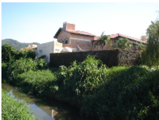
Foto 3 - Edificações privadas na margem do curso d'água. Data: 14/03/2008.
