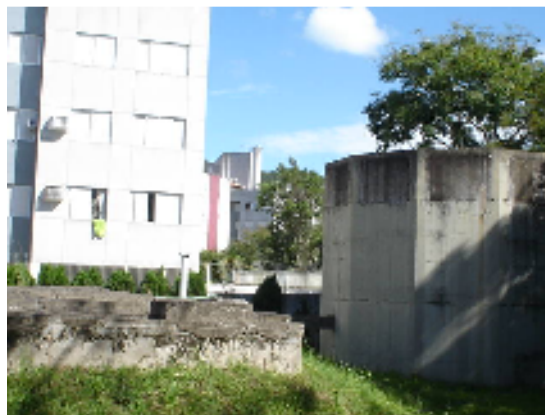
Foto 24 – Estação de tratamento de esgoto. Data: 26/03/2008.
