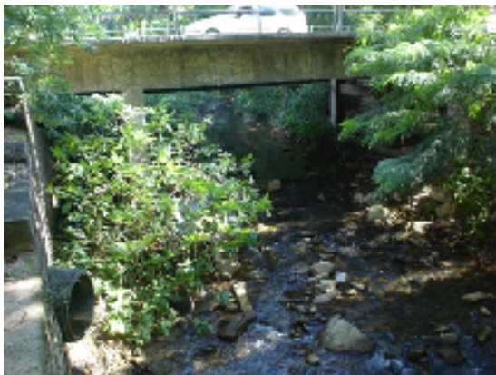
Foto 29 – Seção transversal – Rua Sebastião Laurentino da Silva. Data: 26/03/2008.
