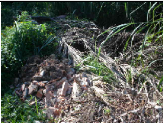
Foto 30 – Depósito de resíduos da construção civil na margem. Data: 26/03/2008.
