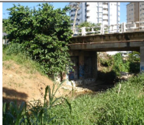
Foto 11 - Seção transversal ponte na Rua João Pio Duarte. Data: 14/03/2008.
