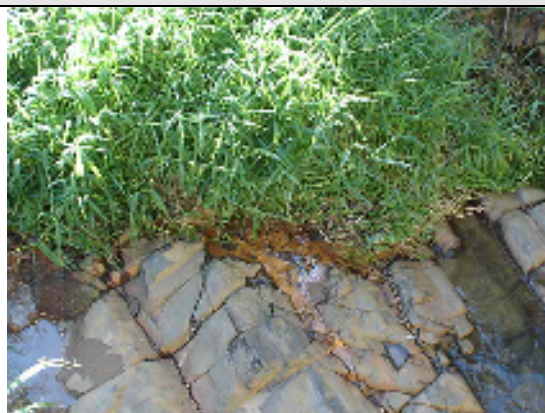
Foto 31 – Lançamento de efluentes no curso d'água. Data: 26/03/2008.
