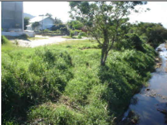
Foto 7 – Substituição da vegetação nativa por arbustos e capim. Via pública na zona de proteção legal. Data: 14/03/2008.
