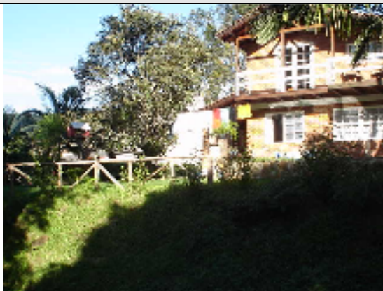
Foto 38 – Edificação privada na margem. Data: 26/03/2008.
