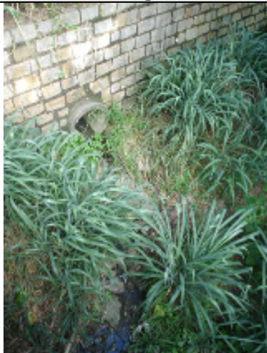
Foto 32 - Construção de muro na margem do rio e lançamento de efluentes domésticos. Data: 26/03/2008.
