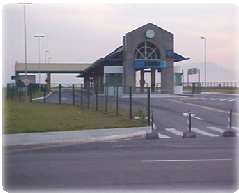
Figura 20 – Terminal TISAC Fonte: PMF, 2006
