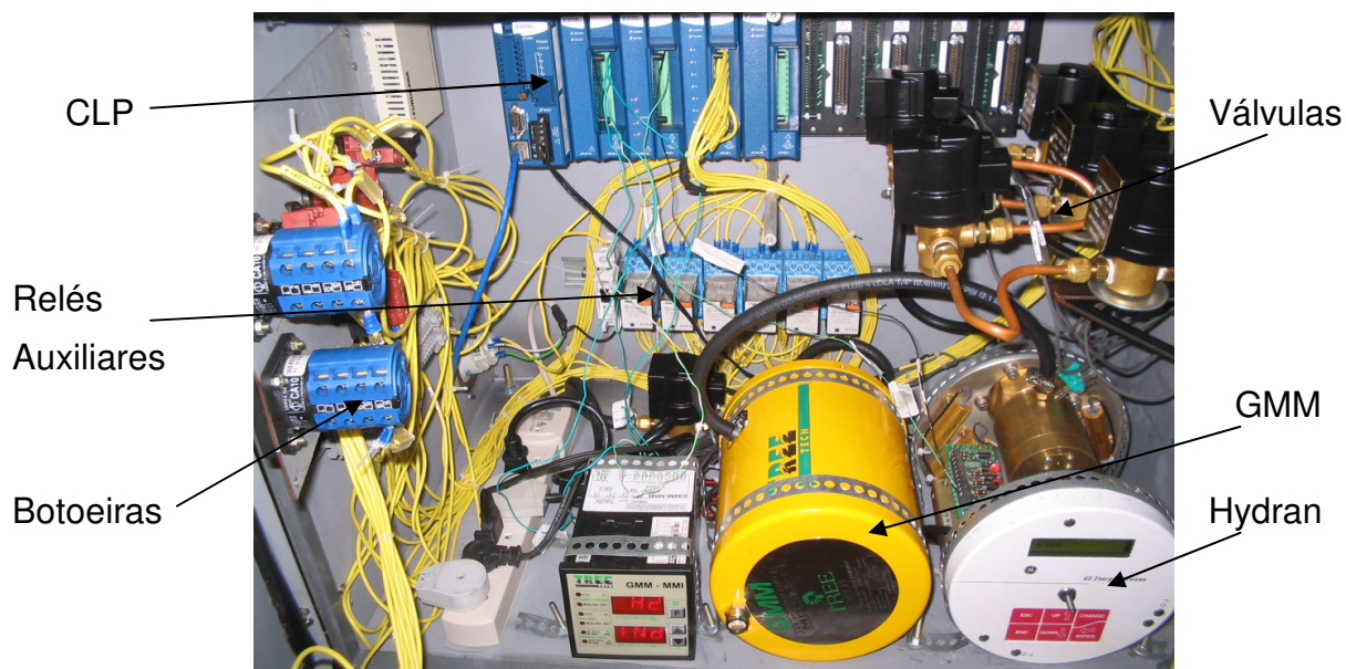
Figura 3.2 – Vista do interior do módulo principal do MAGO I.
