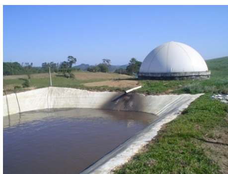
Figura 13 – Biodigestor e lagoa de armazenamento da propriedade P1.
