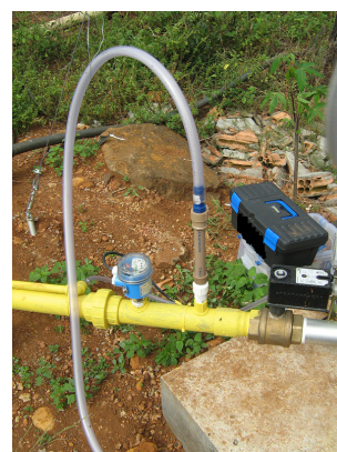
(c) Conexão entre mangueira do adaptador e a saída do biogás, numa das propriedades de Concórdia.
