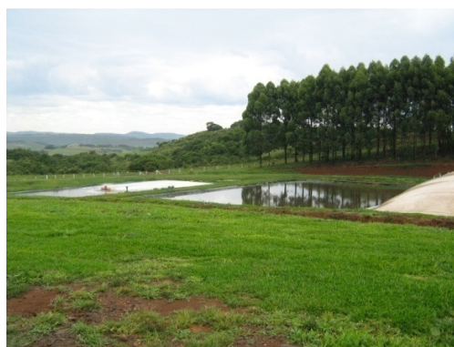
(b) Biodigestor seguido da lagoa de armazenamento e da lagoa aerada
