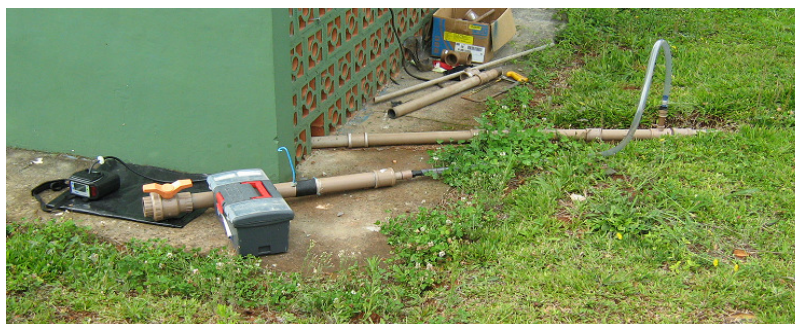
(a) Conexão entre o adaptador e a saída do biogás, na propriedade P8.
