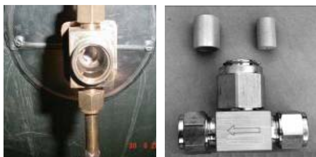
Figura 22 - Local de instalação dos filtros.
