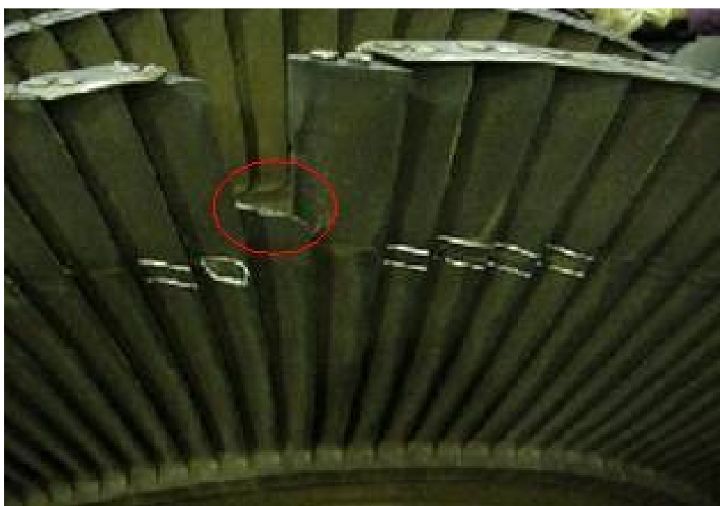
Figura 19 – Estágio onde ocorreu fratura e trincamento de palhetas, salientando os detalhes da palheta fraturada no círculo vermelho.
