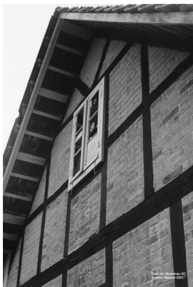
Figura 32 - Casa de colono alemão construída com a técnica enxaimel – Blumenau / SC. Fonte: Acervo pessoal.
