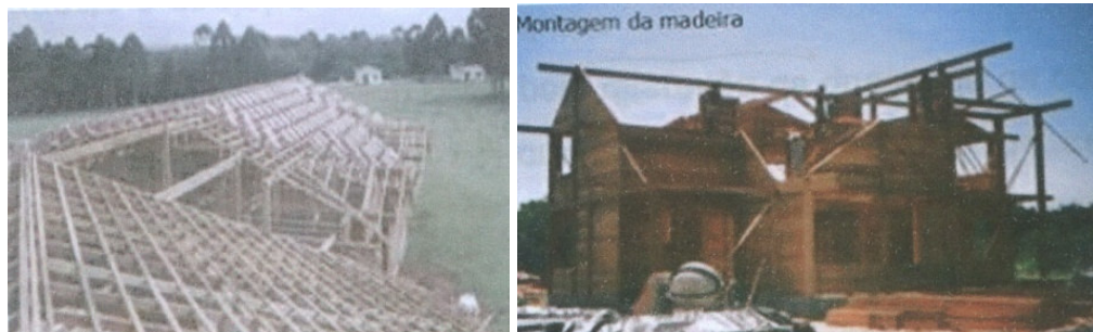
Figura 92 – Montagem do madeiramento. Fonte: Block-Haus, 2008.
