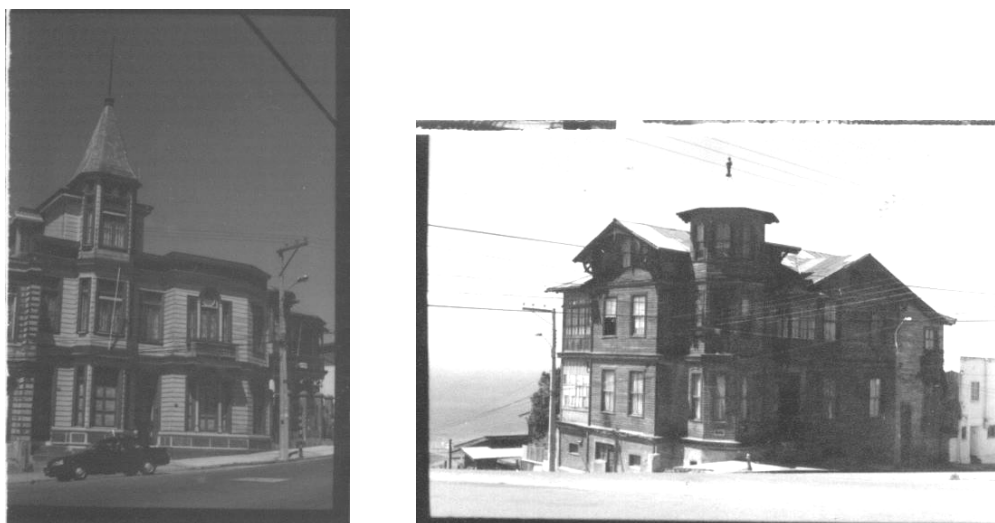
Figura 12 – Arquitetura residencial de Valparaíso - Chile.
