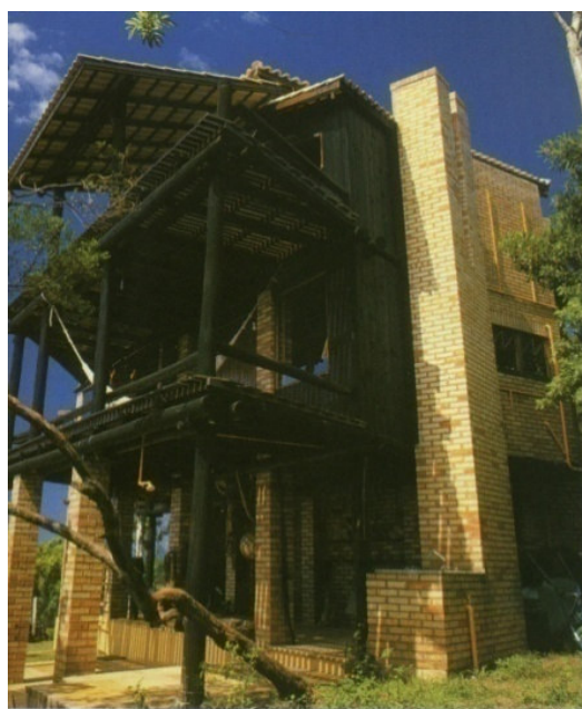
Figura 88 – Vista do madeiramento da varanda da casa do Campeche. Fonte: Piazza, 2000
