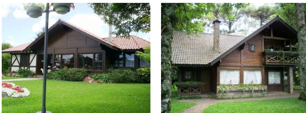
Figura 94 – Projetos personalizados. Fonte: Block-Haus, 2008.
