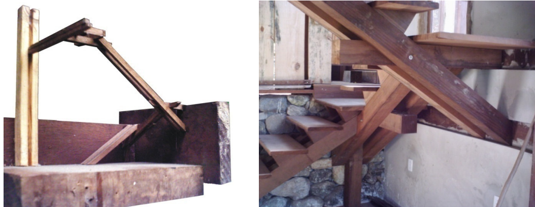
Figura 79 – Maquete de estudos, vistas e detalhamento da escada. Fonte: GRUPOTABA ARQUITETURA.
