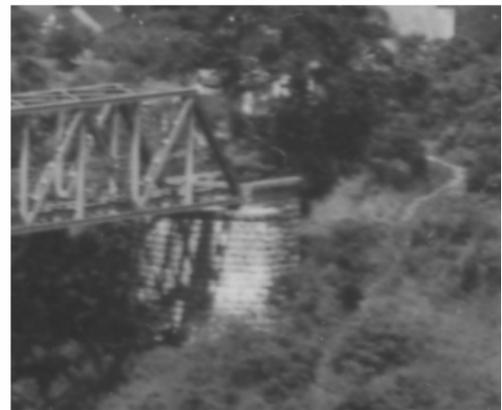
**Figura 94 - Detalhes da ausência das cabeceiras na Ponte de ferro Aldo Pereira de Andrade - 1934**
