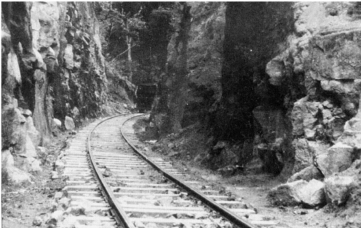
**Figura 92 - Linha de trem assentada no corte efetuado na montanha rochosa – Salto Pilão**
