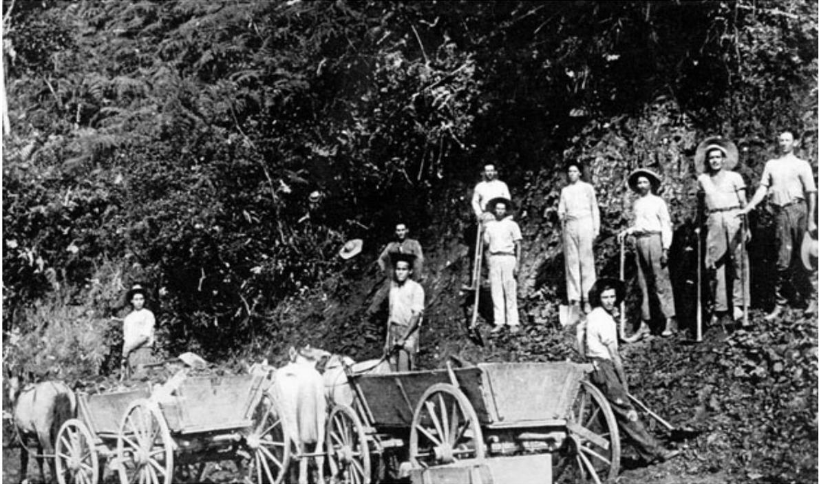
**Figura 65 - Construção da ferrovia, trajeto para Hansa-Hammonia, veículos de tração animal (carroções) em atividade na abertura da ferrovia, feita com pás e picaretas**
