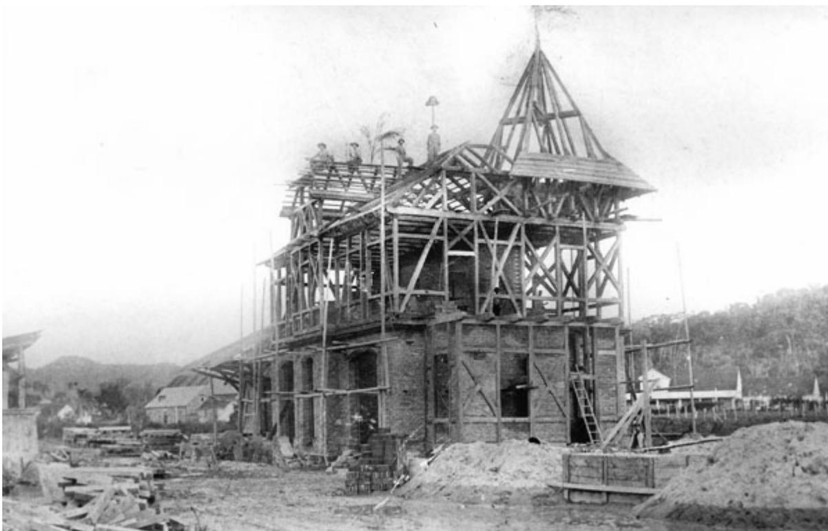
**Figura 152 - Construção da primeira estação de Blumenau, usando a técnica construtiva enxaimel (estrutura de madeira e fechamento em tijolo maciço) - 1908**
