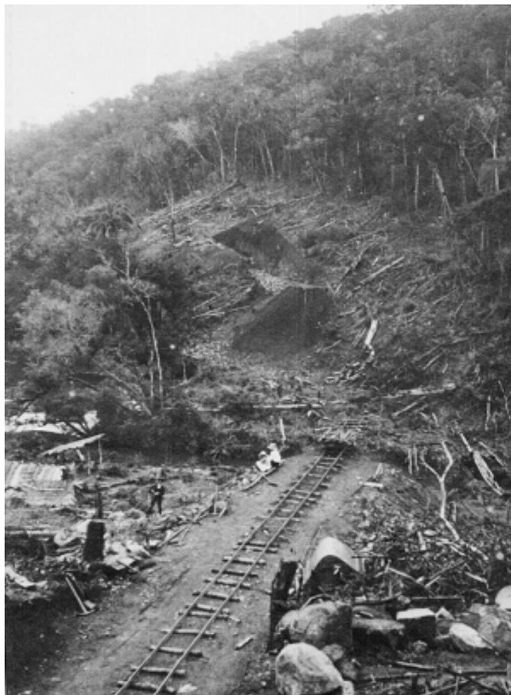
**Figura 82 - Construção do trecho Subida – Detalhes do assentamento dos trilhos provisórios**
