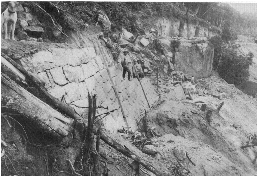
**Figura 62 - Construção Trecho Subida – Lontras. Contenção do barranco - muro de arrimo feito com pedras graníticas da região**
