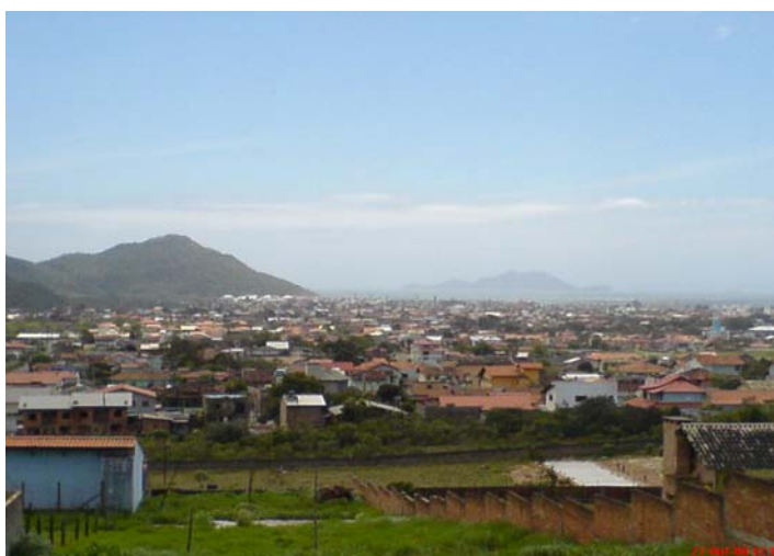
Figura 13 - Ocupação urbano-turística adensada no bairro Sítio do Capivari de Baixo em primeiro plano. Ao fundo vê-se o morro da Feiticeira, limite norte da praia e o mar. Out/2008.
