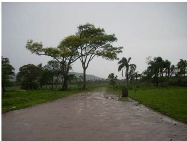
Figura 55 - Acesso calçado a novo condomínio em construção no caminho entre as localidades de Costa de Dentro e Costa de Cima. Nov/2008.
