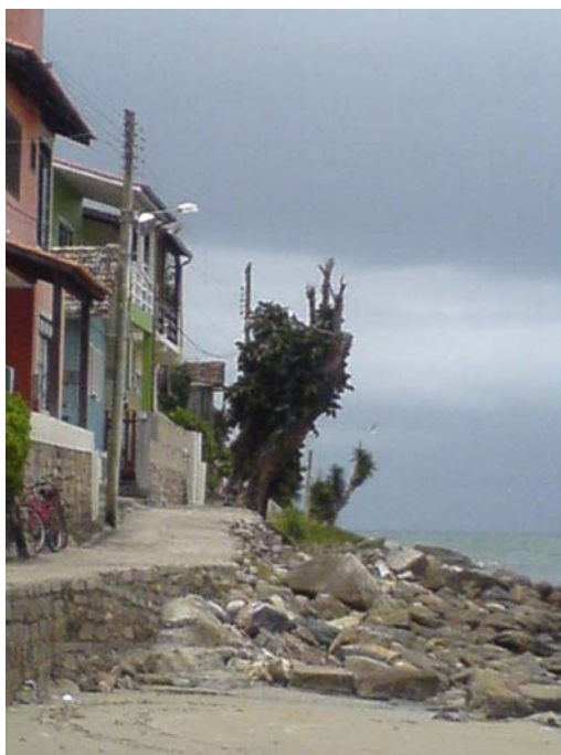
Figura 46 - Vial de pedestres sobre o rochedo que acessa as edificações ali construídas. Mar/08
