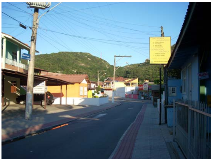
Figura 29 - Comércio sobre um dos eixos de chegada ao centro do balneário. Abr/2008.
