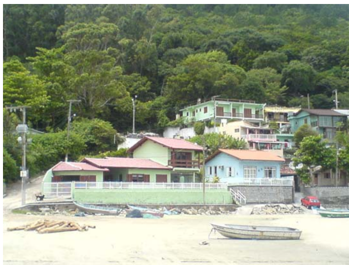
Figura 48 - Edificações e o Cemitério Municipal sobre a viela em cota superior, na encosta do Morro da Lagoinha sobre a enseada. Mar/08
