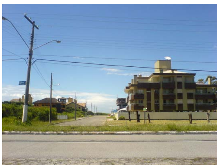
Figura 53 - Loteamento dos Açores com tipologia de edifícios multifamiliares– Nov/2008.
