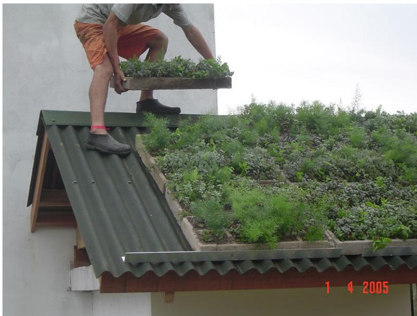
Figura 17 – Montagem da Ecotelha (Fonte: ECOTELHADO, 2006)
