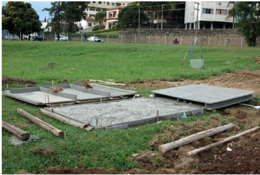
Figura 48 – Montagem no solo dos painéis
