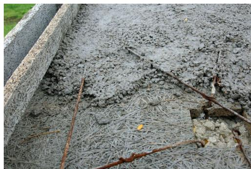
Figura 53 – Concretagem da laje e sua ferragem
