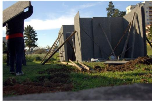
Figura 49 – Montagem dos painéis com escoras
