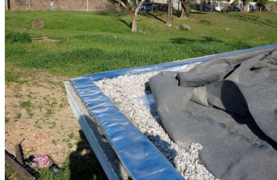
Figura 57 – Colocação da brita no perímetro da cobertura
