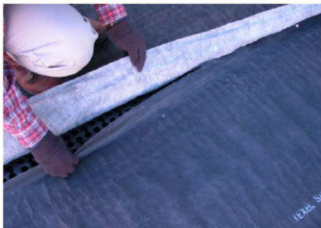
Figura 29 – Sobreposição da camada filtrante (Fonte: J-DRain GRS, 2006)
