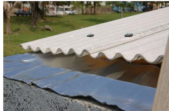
Figura 62 - Calha localizada na base da cobertura
