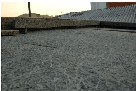
Figura 52 – Montagem das formas da laje
