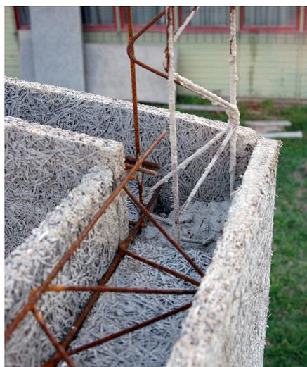
Figura 50 – Concretagem dos pilares
