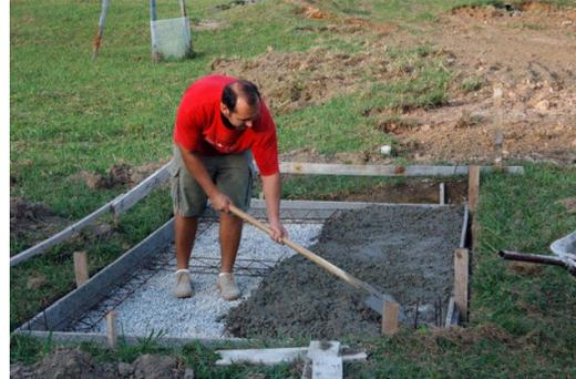
Figura 47 – Concretagem do radier
