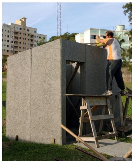
Figura 51 – Concretagem das vigas
