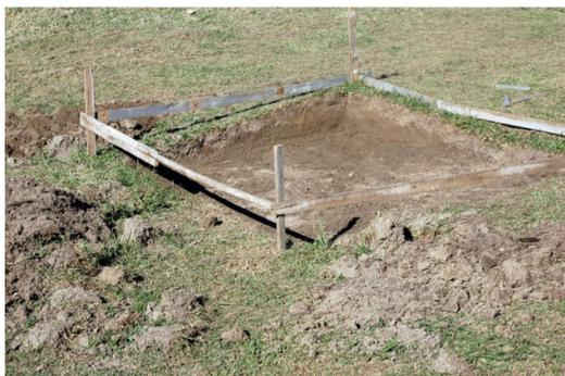
Figura 42 – Escavação e nivelamento
