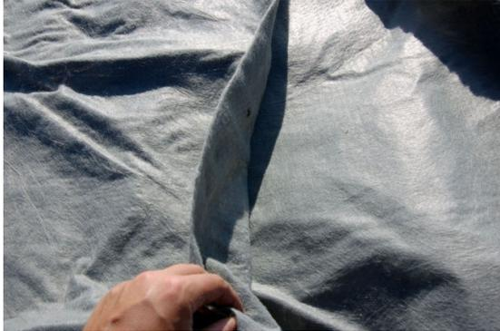
Figura 56 – Sobreposição de 20 cm da geomembrana
