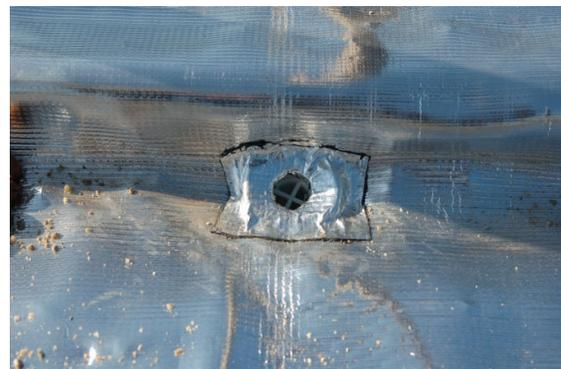
Figura 55 – Drenagem para água pluvial excedente
