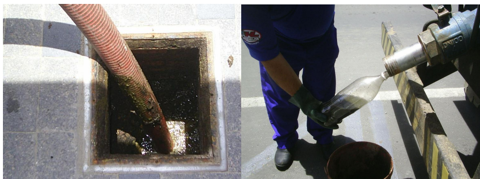
Figura 2 Aspiração de tanque séptico e coleta de material
