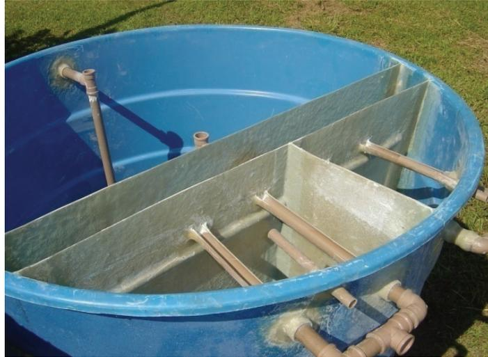
Figura 03. Estrutura do decanto-digestor e biofiltros aerados submersos.
