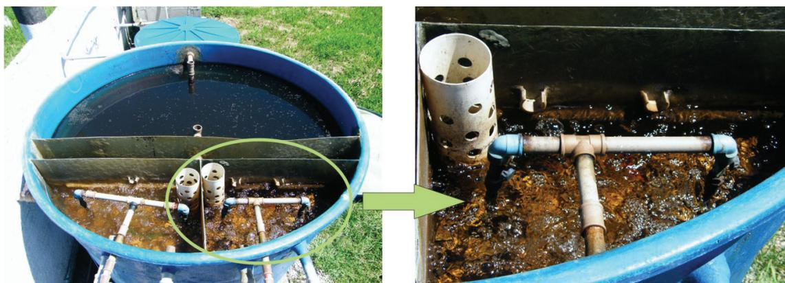
Figura 09. Decanto-digestor e biofiltros aerados submersos em operação.
