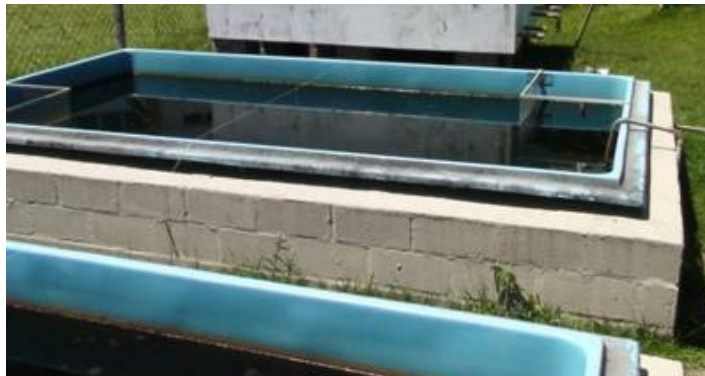
Figura 6: Lagoa 2 com aeração desligada.
