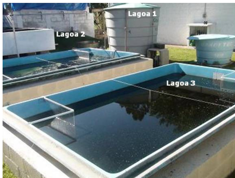
Figura 5: Lagoas de estabilização piloto para tratamento biológico.
