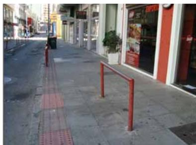
**Figura 32:** *Guard-rails* desprovidas de piso tátil de alerta.
