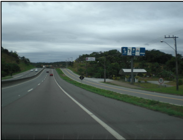
Figura 10 - Via marginal no Trecho Norte (km 50).
