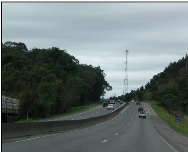
Figura 7 - Situação física do Trecho Norte (km 46).
