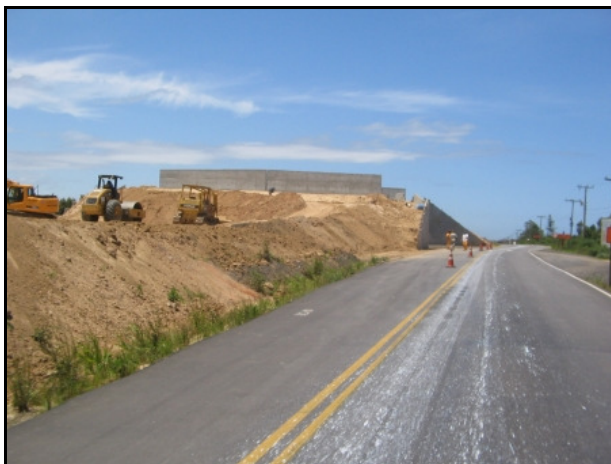
Figura 18 - Trecho Sul – obras de duplicação (Km 293) em 2007.
