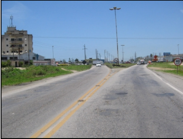
Figura 16 - Interseção no Trecho Sul (Km 332) em 2004. Fonte: ESGA (2008).
