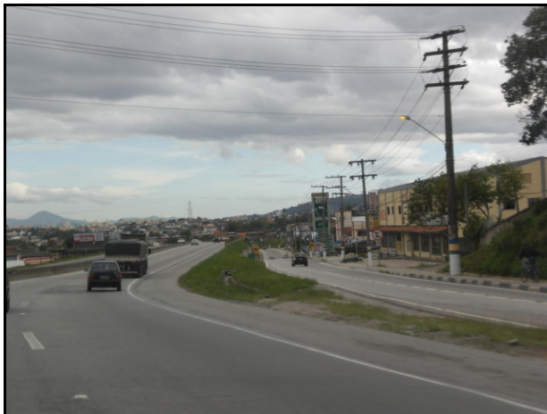
Figura 14 - Via marginal no Trecho da Grande Florianópolis (Km 198).
