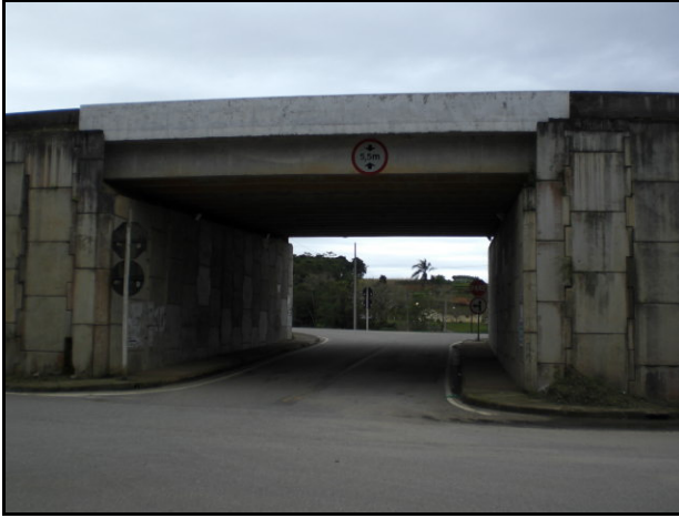
Figura 9 - Viaduto no Trecho Norte (Km 82).
