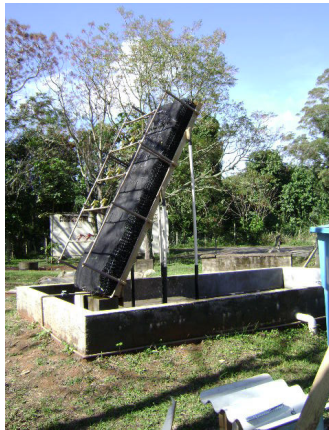
Figura 4 Vista do sistema piloto de evaporação de lixiviados (painel evaporativo e reservatório de evaporação)
