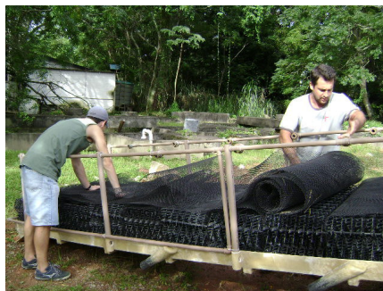
Figura 12 Colocação da tela no painel de evaporação
