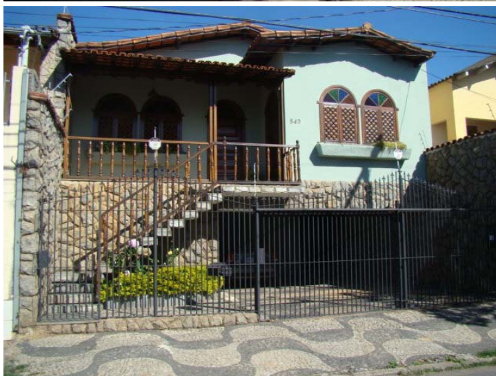
Figuras 11 e 12: Exemplos na cidade de Belo Horizonte em Minas Gerais. Mesmo que a construção civil não possua um caráter tão industrial como algumas outras formas de produção, as figuras demonstram a busca pelo aspecto artesanal na arquitetura em um edifício multifamiliar e em uma residência unifamiliar. Fonte figura 11: Imagem disponível no site www.skyscrapercity.com/showthread.php-JardimAmerica107-BH , acessado em fevereiro de 2009. Fonte figura 12: Imagem disponível no site www.skyscrapercity.com/showthread.php-JardimAmerica038-BH , acessado em fevereiro de 2009.
