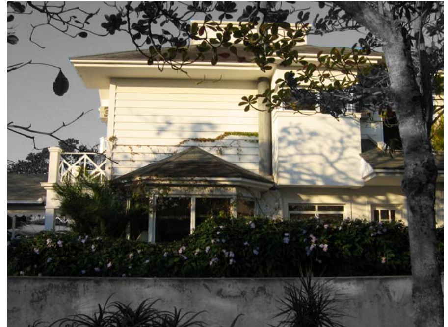
Figura 47: Nesta residência em Canasvieiras, construída na década de 2000, observamos a presença da bay-window , do telhado inclinado com telha tipo shingle , das cimalthas junto à varanda e do reboco simulando o efeito das tábuas de madeira. Fonte: Autor.
