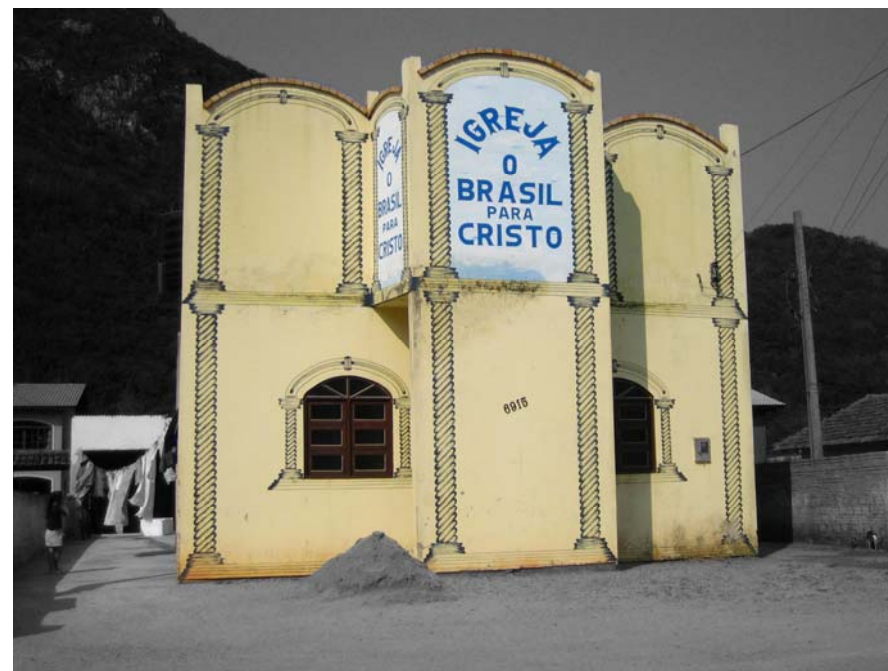
Figura 76: Até mesmo a igreja pobre quer ser nobre. Nesta igreja localizada no Pântano do Sul observamos que a aspiração ao clássico é maior do que as limitações econômicas. O tratamento historicista fica por conta de uma simples pintura onde se destacam as rebuscadas colunas salomônicas na fachada frontal. Fonte: Fotografia de autoria do arquiteto e urbanista Marcelo Cabral Vaz.
