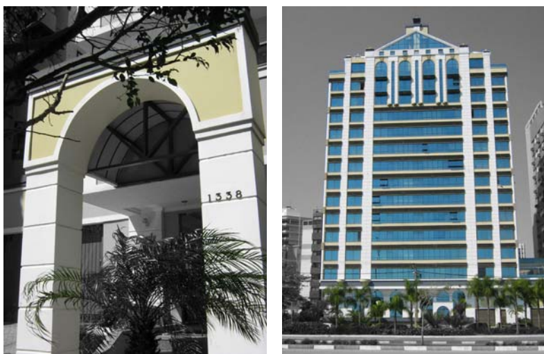
Figuras 60 e 61: Mais exemplares que têm como empreendedor a construtora Santa Fé e que foram projetados em parceria entre o engenheiro Paulo César Maciel da Silva e a arquiteta Margarida Milani. Pelo volume de edificações em altura executados por esta parceria, pode-se observar que é expressiva a ação destes agentes na consolidação dos edifícios em altura historicistas de Florianópolis. Fonte: Autor.
