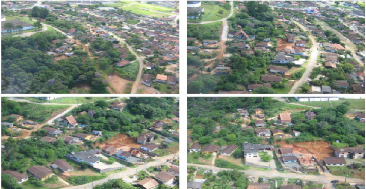
Figura 44 – Vista aérea de local de deslizamento no Morro da Caixa D'água, bairro Itaúm, Joinville-SC
