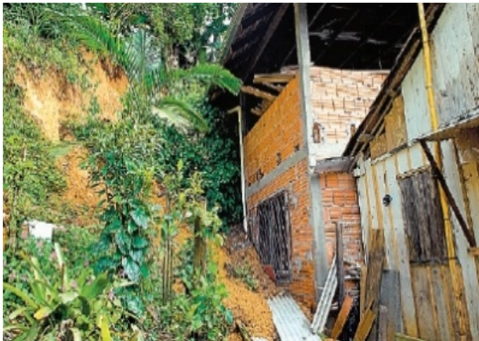
Figura 6 – Escorregamentos em Joinville
