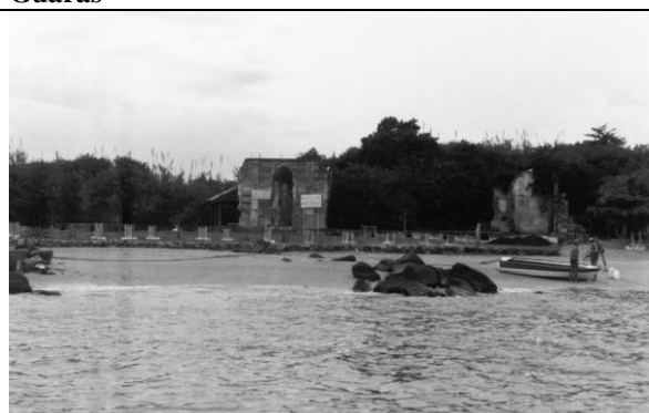
Fig. 1.6 – Ruínas do Hospital de Isolamento da Ilha dos Guarás
