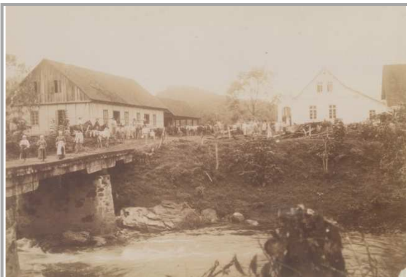
Figura 28: Fundação da “Firma Weege”, datada de 1906 Fonte: MWW
