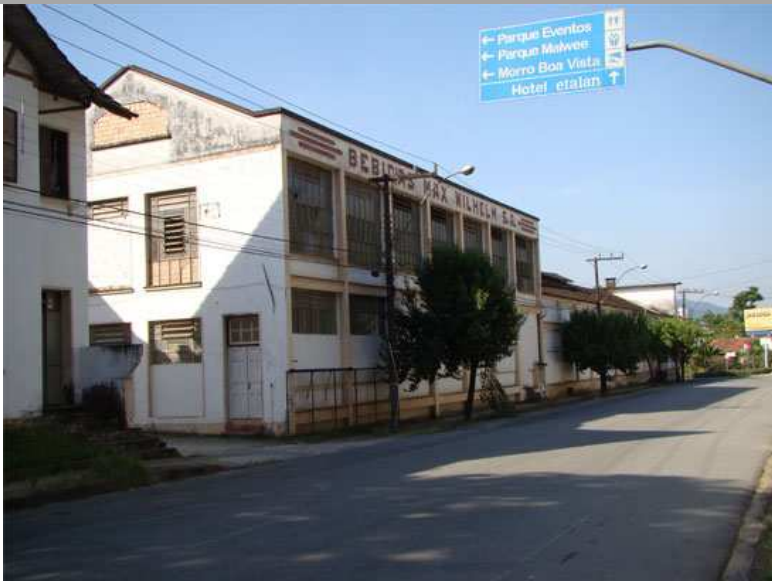
Figura 60: Vista geral da indústria em fevereiro de 2010, antes da demolição
