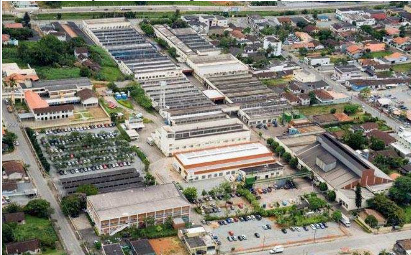
Figura 77: Vista geral da WEG I (s/d)
