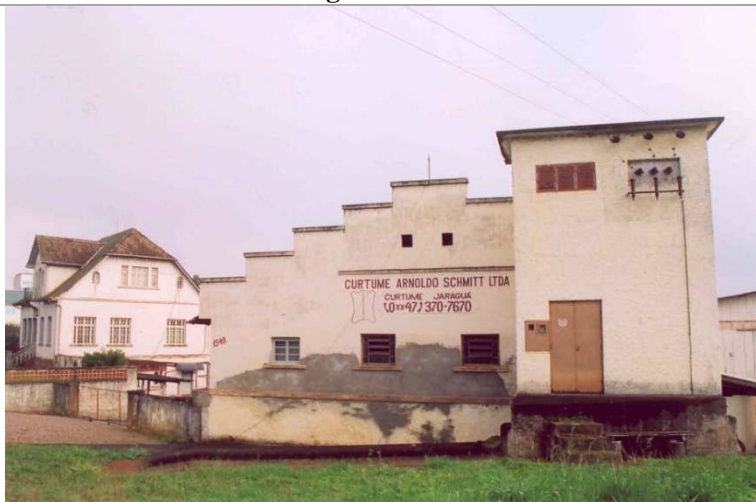
Figura 45: Vista do galpão com a residência Schmitt ao fundo (s/d)
