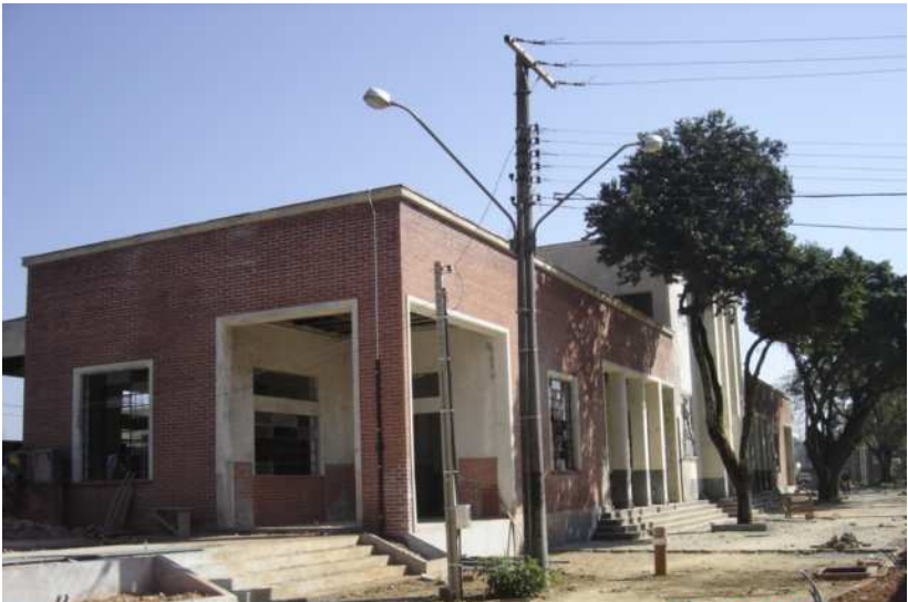
Figura 24: Antiga Estação Ferroviária em obras. Fonte: Soto, 2008
