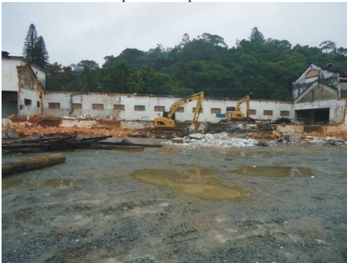
Figura 61: Trabalhos de demolição em abril de 2010
