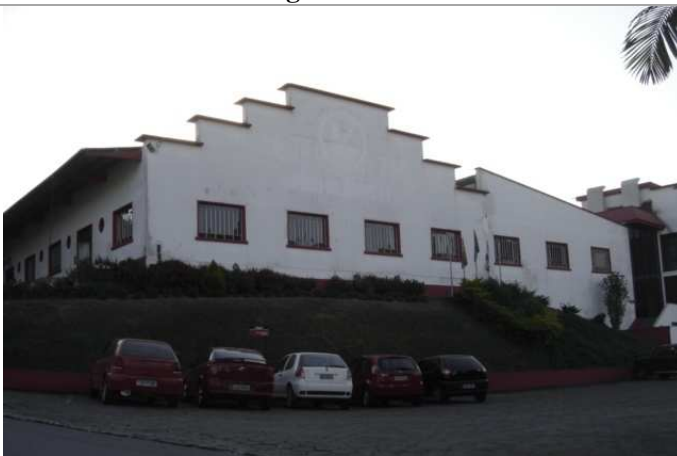
Figura 67: Vista da fachada do galpão principal.
