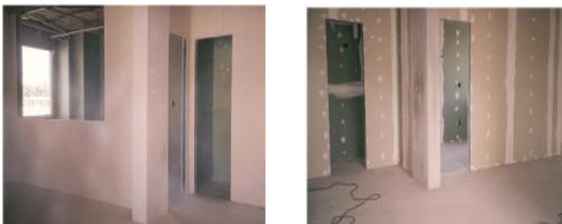
Figura 5.9 - a) Fechamento das vedações e b) Realização dos acabamentos. Fonte: Lima (2000)
