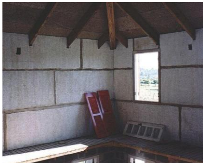
Figura 5.33 – a) placas recortadas para melhor aproveitamento e b) Colocação das PCMM orientadas horizontalmente. Fonte: Defferrari (1999)
