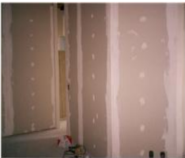
Figura 5.11 a – Realização dos acabamentos e b – Realização dos acabamentos – ângulos externos. Fonte: Lima (2000)
