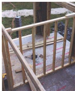
Figura 5.31 – a) Marcação de montantes no primeiro pavimento e b) formação dos quadros de madeira de pinus autoclavado. Fonte: Defferrari (1999)
