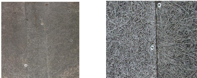
Figura 5.53 – a) Fixação das placas com pregos galvanizados e b) Detalhe da fixação. Fonte: Construpex (2009)
