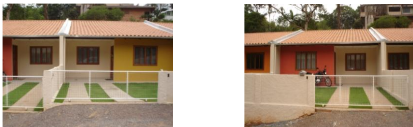
Figura 5.38 – a) e b) Vista da fachada das casas no mesmo nível
