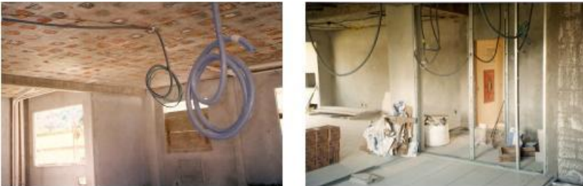
Figura 5.7 - a) Eletrodutos fixados na laje e b) Eletrodutos na fase de montagem dos perfis verticais Fonte: Lima (2000).
