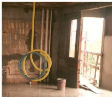
Figura 5.4 – a) parede externa em alvenaria com blocos cerâmicos e b) montagem dos perfis para a colocação das CGA nas divisórias internas. Fonte: Lima (2000)
