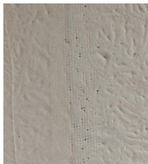
Figura 5.56 – a) Tratamento de juntas entre as placas e b) detalhe da fita de união entre as placas e posterior acabamento com gesso.
