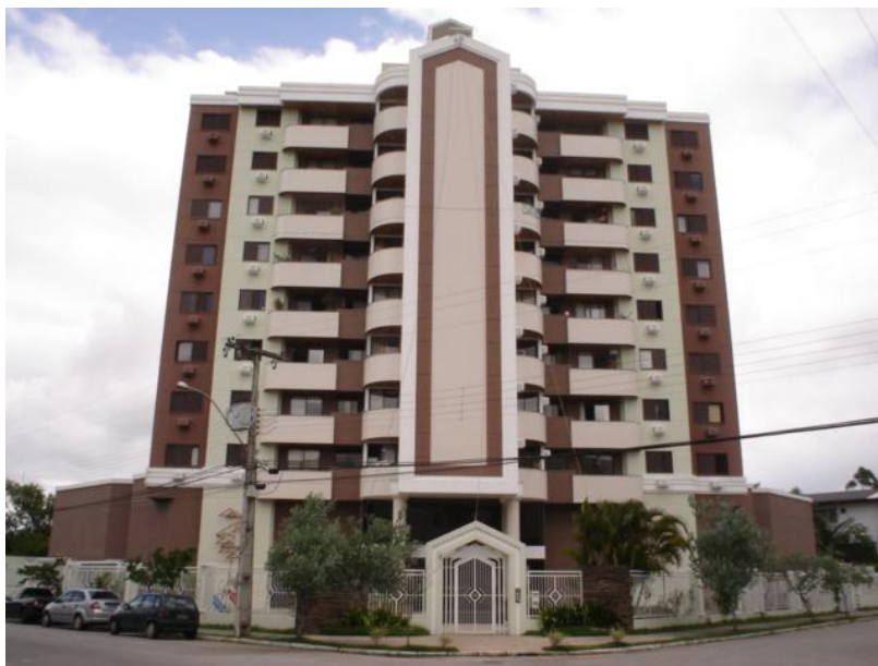
5.14 - Fachada do Edifício Puerto Madero
