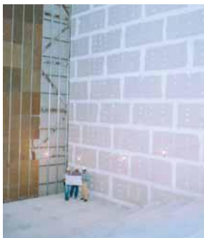
Figura 2.4 – a) Vedação vertical interna com CGA e b) fechamento de uma vedação com CGA.
