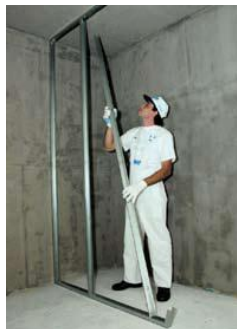
Figura 4.1 – a) Estrutura de perfis de aço galvanizado. Fonte: Luca (2000) e b) montagem da estrutura. Fonte: Placo (2009)
