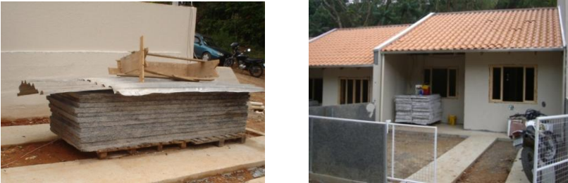
Figura 5.46 – a) Estocagem das placas e b) Estocagem das chapas na varanda frontal.
