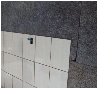
Figura 5.59 – a) Aplicação de azulejos diretamente sobre a PCMM. Fonte: Construpex (2009) e b) Aplicação de azulejo em meia parede na área de serviço e acabamento.
