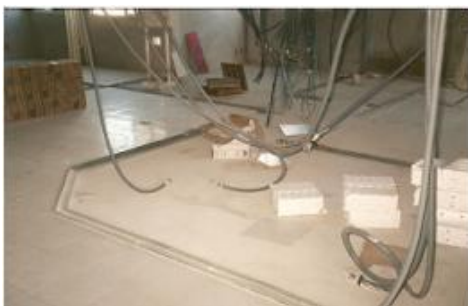
Figura 5.6 - a) Montagem das guias e b) Colocação dos montantes. Fonte: Lima (2006).
