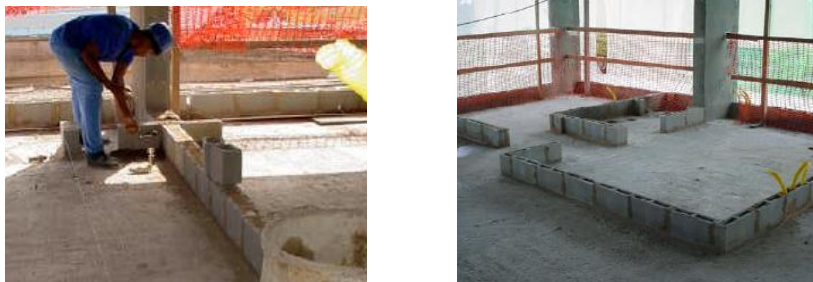
Figura 2.2 – a) Marcação do local para a montagem de uma vedação interna de bloco de cimento e b) Primeira fiada de blocos.
