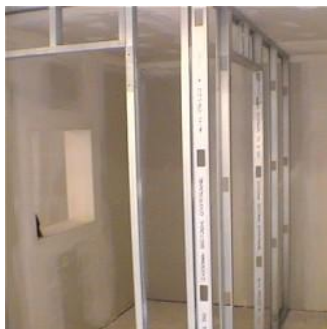
Figura 4.1 – a) Estrutura de perfis de aço galvanizado. Fonte: Luca (2000) e b) montagem da estrutura. Fonte: Placo (2009)
