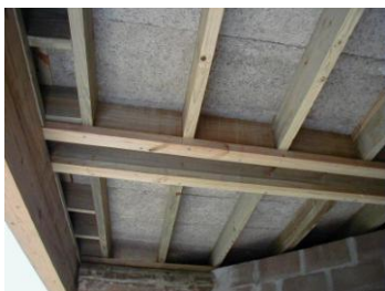
Figura 5.34 – a) do térreo observam-se as placas sobre barrotes e b) montagem do piso em PCMM do pavimento superior. Fonte: Defferrari (1999)
