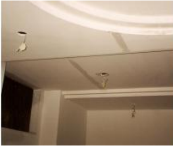
Figura 5.10 a – Saídas elétricas para lâmpadas e b – Forro finalizado. Fonte: Lima (2000).
