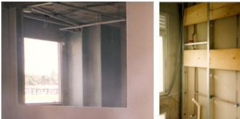
Figura 5.8 - a) Tubulações hidráulicas no forro, b) Colocação dos reforços nos montantes e tubulação hidráulica. Fonte: Lima (2000).
