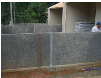
Figura 5.55 – a) montagem do muro com placas de madeira mineralizada com montantes de aço galvanizado e b) muro revestido com argamassa de cimento e areia. Fonte: Construpex (2009)
