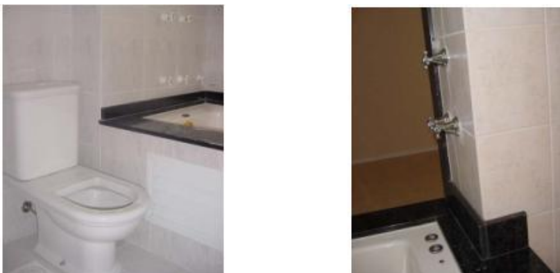
Figura 5.13 a – Revestimento cerâmico da banheira, piso e parede do banheiro e b – revestimento cerâmico do shaft no banheiro. Fonte: Bolzan (2000)
