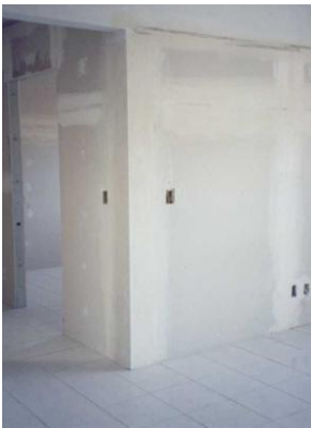
Figura 5.18 - a) execução das vedações com CGA e b) divisória do banheiro com uma das faces formada por duas CGA. Fonte: Bolzan (2002).
