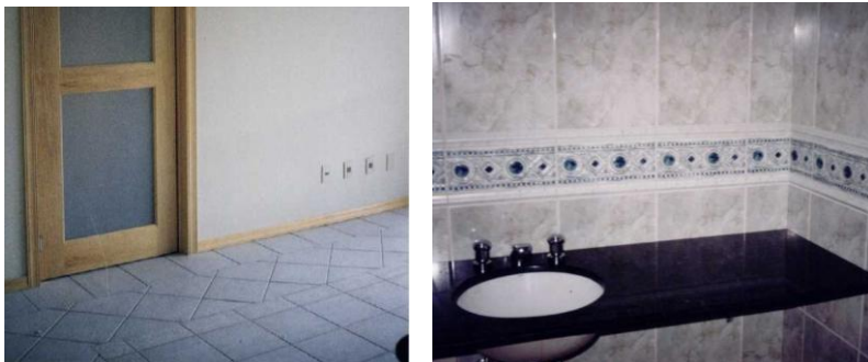
Figura 5.21 – a) Revestimento cerâmico no piso e b) Revestimento cerâmico nas paredes do banheiro de uso comum.
