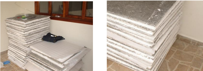
Figura 5.47 – a) Estocagem das placas quadradas do forro e b) Empilhamento das placas com proteção da camada de gesso.
