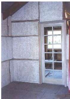
Figura 5.33 – a) placas recortadas para melhor aproveitamento e b) Colocação das PCMM orientadas horizontalmente. Fonte: Defferrari (1999)
