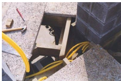
Figura 5.34 – a) do térreo observam-se as placas sobre barrotes e b) montagem do piso em PCMM do pavimento superior. Fonte: Defferrari (1999)
