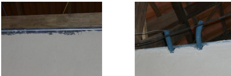
Figura 5.48 - a) Guia metálica horizontal superior fixado na estrutura do telhado e b) guia fixada na extremidade superior da vedação. Fonte: Construpex (2009)
