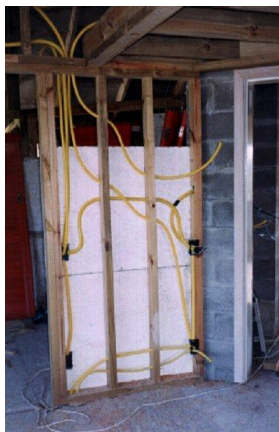
Figura 5.32 – a) Estrutura interna com passagens de eletrodutos em vedações verticais internas e b) em vedações verticais externas. Fonte: Defferrari (1999)
