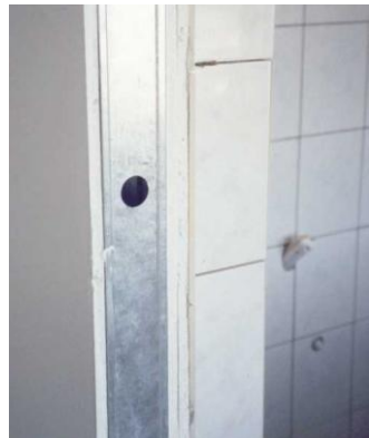
Figura 5.18 - a) execução das vedações com CGA e b) divisória do banheiro com uma das faces formada por duas CGA. Fonte: Bolzan (2002).
