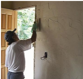
Figura 5.57 – a) Aplicação de argamassa industrializada e b) Desempeno e finalização da superfície. Fonte: Construpex (2009)
