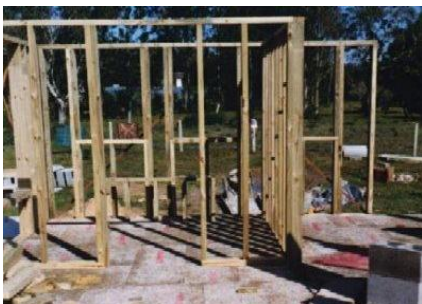
Figura 5.31 – a) Marcação de montantes no primeiro pavimento e b) formação dos quadros de madeira de pinus autoclavado. Fonte: Defferrari (1999)
