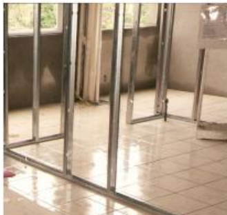
Figura 5.4 – a) parede externa em alvenaria com blocos cerâmicos e b) montagem dos perfis para a colocação das CGA nas divisórias internas. Fonte: Lima (2000)
