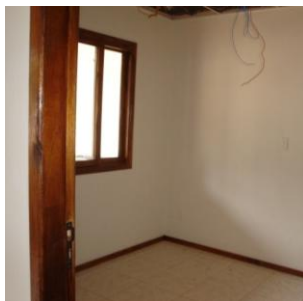
Figura 5.58 – a) Acabamento com pintura interna branca nas paredes e verniz nas esquadrias e b) Pintura externa colorida na parede e verniz nas madeiras
