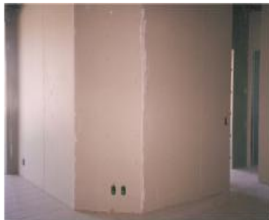
Figura 5.11 a – Realização dos acabamentos e b – Realização dos acabamentos – ângulos externos. Fonte: Lima (2000)
