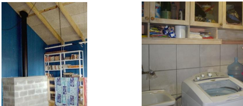
Figura 5.37 – a) Acabamento com pintura e b) azulejos. Fonte: Defferrari (1999)
