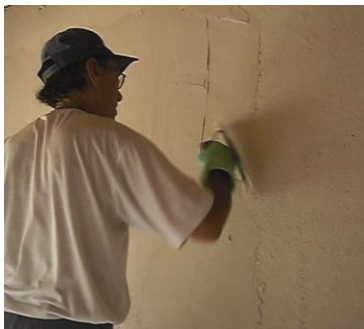
Figura 5.57 – a) Aplicação de argamassa industrializada e b) Desempeno e finalização da superfície. Fonte: Construpex (2009)
