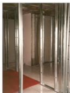
Figura 5.6 - a) Montagem das guias e b) Colocação dos montantes. Fonte: Lima (2006).
