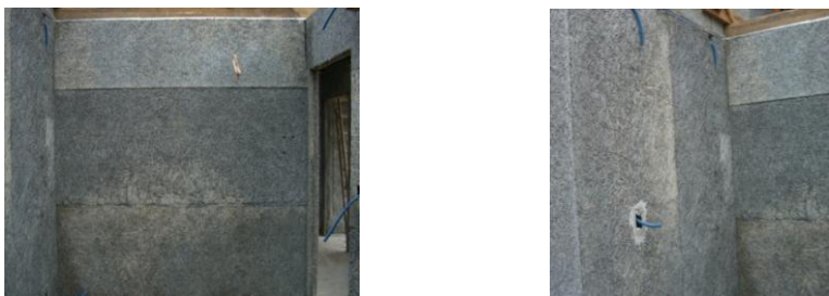
Figura 5.52 – a) Posição horizontalizada das PCMM e b) Posição verticalizada das PCMM. Fonte: Construpex (2009)
