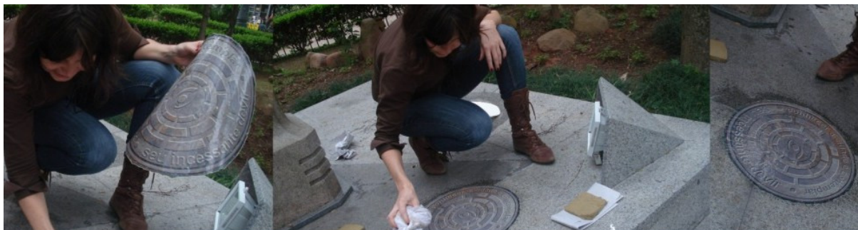
Figura 3.43 - Instalação da obra Saneamento básico , Praça XV Fonte: Fotomontagem da autora, 2009
