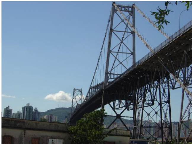
FIGURA 2 – Ponte Hercílio Luz, Florianópolis, SC, 2007. Fonte: o autor.
