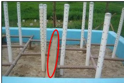
Figura 11: Tubulação de alimentação do sistema com destaque para as divisórias dos filtros.
