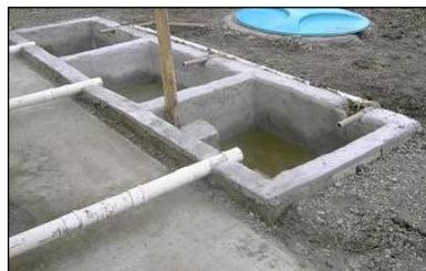
Figura 13: Sistema para extravasar o líquido percolado
