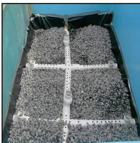
Figura 7: Sistema de coleta do efluente
