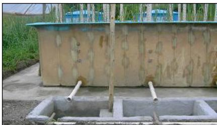
Figura 12: Caixas para armazenamento do líquido percolado.
