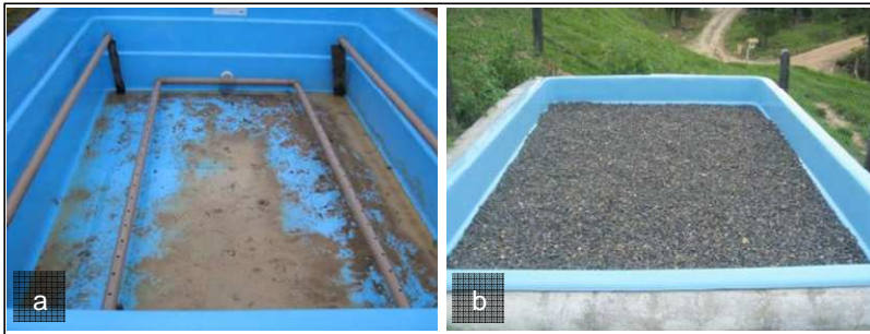
Figura 4 - a) Filtro de pedras com detalhes das tubulações de entrada e saída; b) Filtro de pedras em operação
