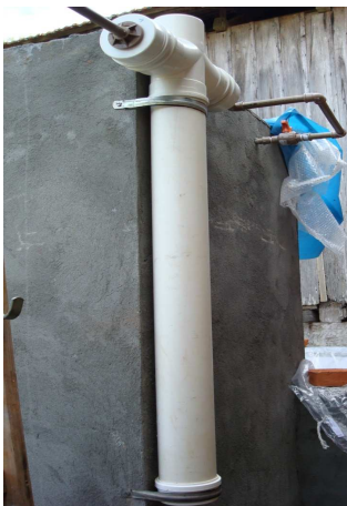
Figura 19: Foto da câmara de carga amortecedora de vazão.
