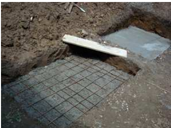
A – Foto da construção da laje de fundo de concreto armado.
