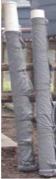
Figura 17: Foto do tubo de PVC ranhurado com bidim.
