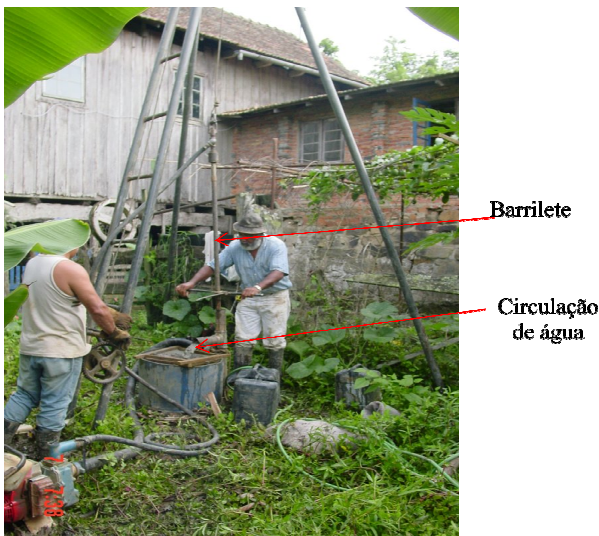
Figura 15: Foto da sondagem a percussão com circulação de água.
