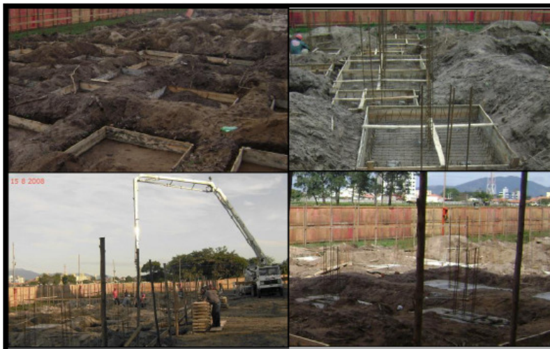
Figura 6.5 – Execução das sapatas de fundação
