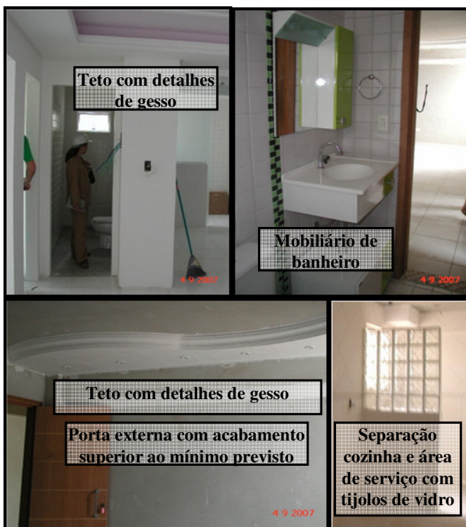
Figura 5.5 – Exemplos de acabamentos dos apartamentos realizados no empreendimento I
