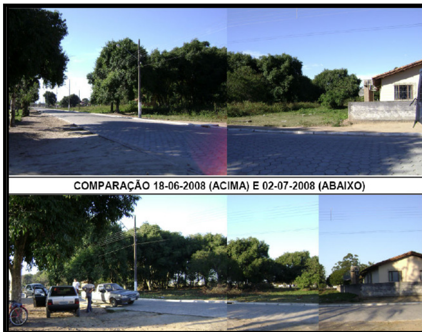
Figura 5.13 – Montagem de fotos da obra do Estudo de Caso 1 – junho e julho de 2008
