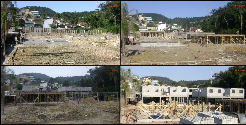
Figura 8.24 – Montagem de fotos - situação da obra em datas próximas à medição
