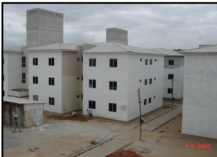
Figura 5.2 – Empreendimento I em construção – E1
