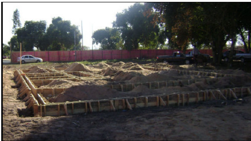
Figura 5.16 – Montagem de fotos do Estudo de Caso 1 – obra em 25/07/2008 (Formas do baldrame do salão de festas)
