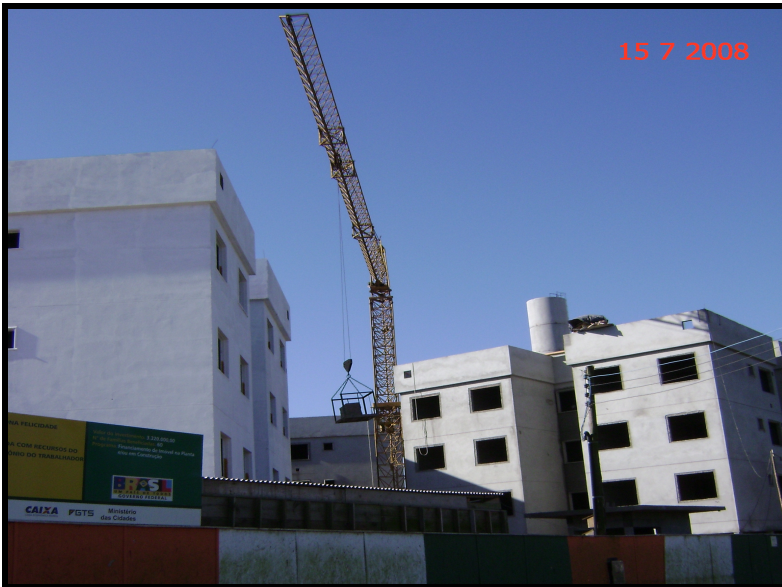
Figura 7.3 – Empreendimento 3 em construção – E2
