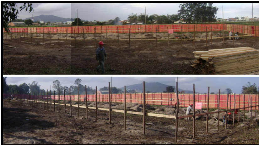
Figura 5.15 – Montagem de fotos do Estudo de Caso 1 – obra em 25/07/2008 (montagem de gabaritos e instalação de tapumes)
