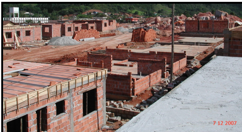
Figura 5.3 – Empreendimento II em construção – E1
