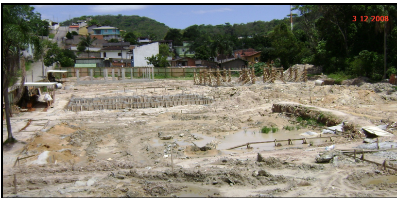
Figura 8.8 - Situação da obra no início de dezembro de 2008 – E2
