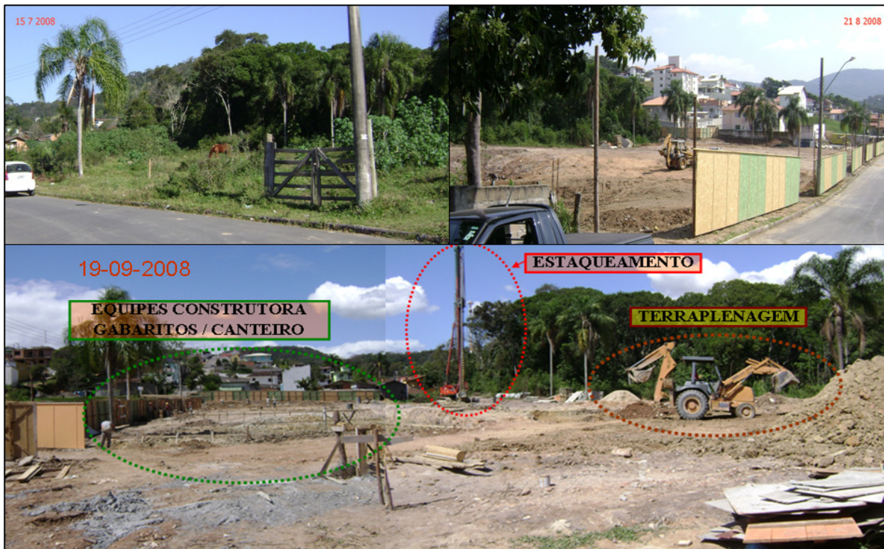
Figura 7.10 – Montagem de fotos da obra do Estudo de Caso 2 entre julho e setembro de 2008
