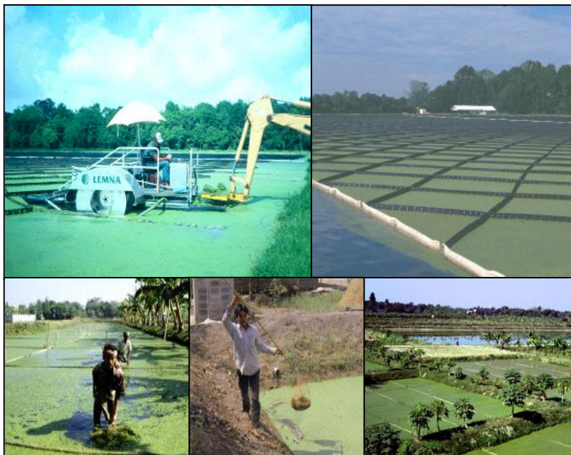
Figura 8: Lagoas de tratamento com lemnáceas nos EUA (acima), na Índia e Taiwan (abaixo). Detalhe para a diferença operacional.
