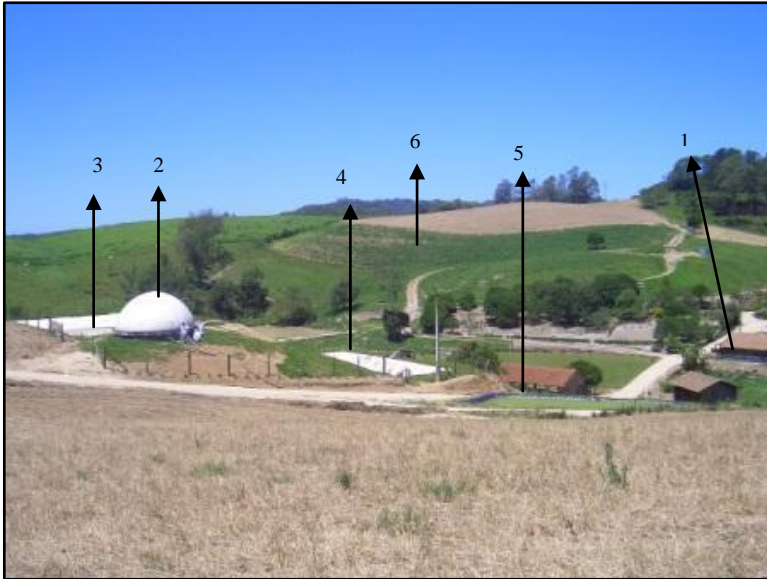
Figura 18: Visão geral da propriedade, com destaque para: esterqueira ou reservatório de recalque (1); biodigestor (2); lagoa de armazenamento (3); lagoa de lemnas 1; (4); lagoa de lemnas 2 (5); área agricultável(6)
