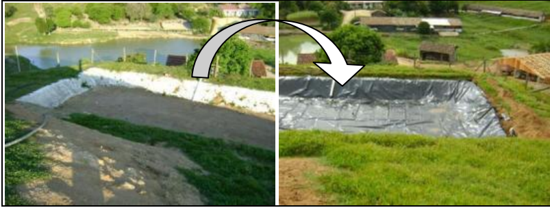
Figura 20: Readequação da lagoa de lemnas 1, com instalação da geomembrana
