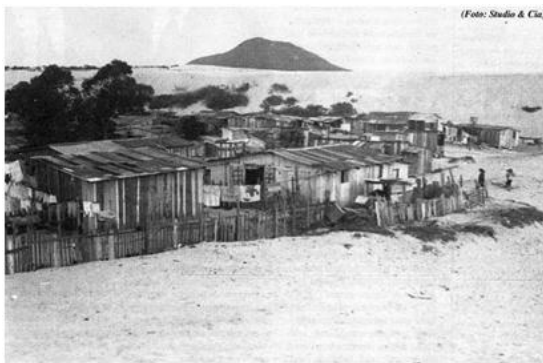
Figura 18 Vila do Arvoredo, Florianópolis. Ocupação irregular em área de dunas – Bairro de Ingleses, Nordeste da Ilha de Santa Catarina. (POMARICO/SUGAI/2004)
