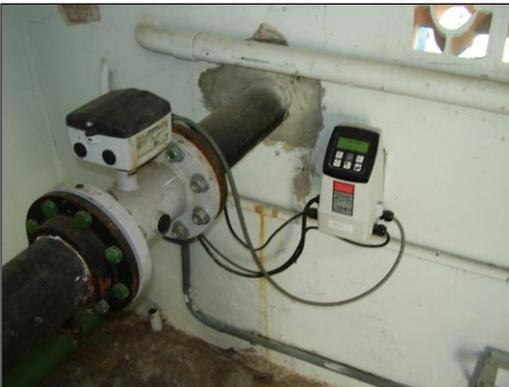
Figura 09. Macromedidor instalado no SAA Capinzal/Ouro.
