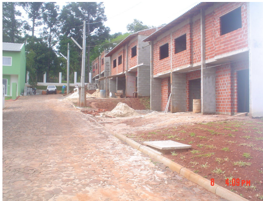
Figura 32 - Foto do residencial em fase de construção Fonte: Acervo da autora
