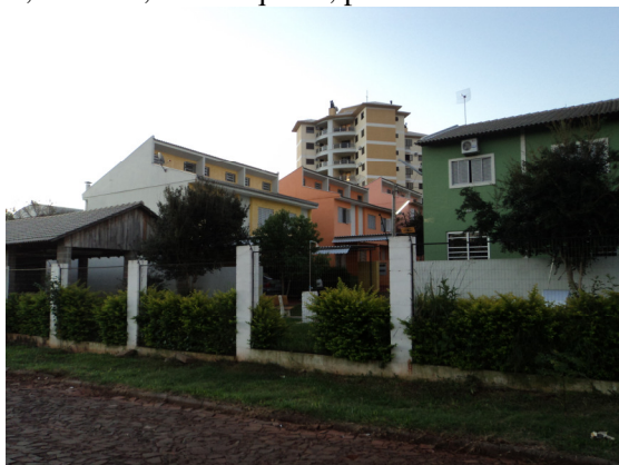
Figura 29 - Foto da edificação do lado esquerdo
