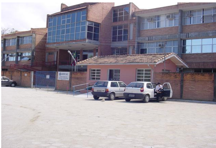
Foto registrada por Costa (2006) – visão da entrada da escola
